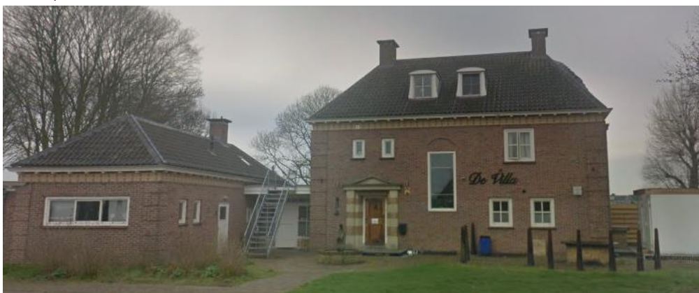
Bestaand hoofdgebouw Schellestraat 2
