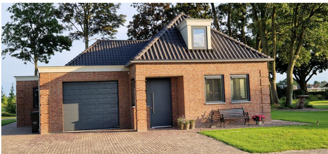
Bestaand bijgebouw Schellestraat 2b
