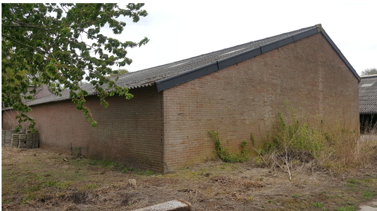
De opslagloods, hieraan zullen geen werkzaamheden plaatsvinden. Foto: B. Verhoeven | Ecoresult B.V.
