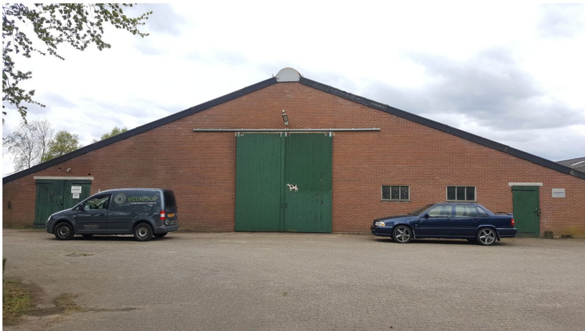
Voorzijde van de te slopen koeienstal. Foto: B. Verhoeven | Ecoresult B.V.
