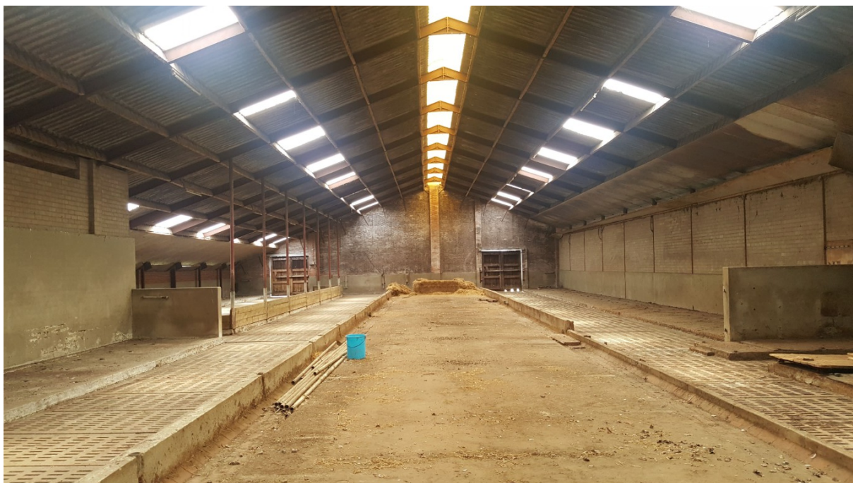
Binnenzijde van de te slopen koeienstal. Foto: B. Verhoeven | Ecoresult B.V.
