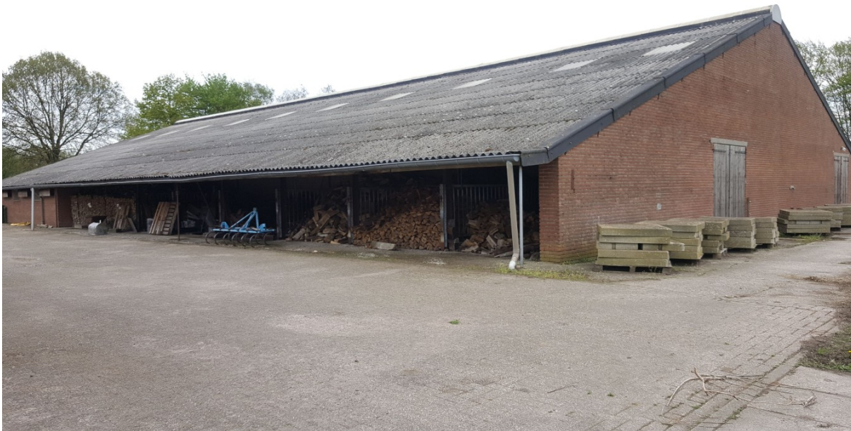
Achtergevel en westelijk zijgevel met afdak van de te slopen koeienstal. Foto: B. Verhoeven | Ecoresult B.V.
