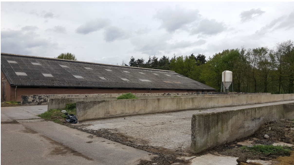
Te verwijderen sleufsilo's en de oostzijde van de te slopen koeienstal. Foto: B. Verhoeven | Ecoresult B.V.
