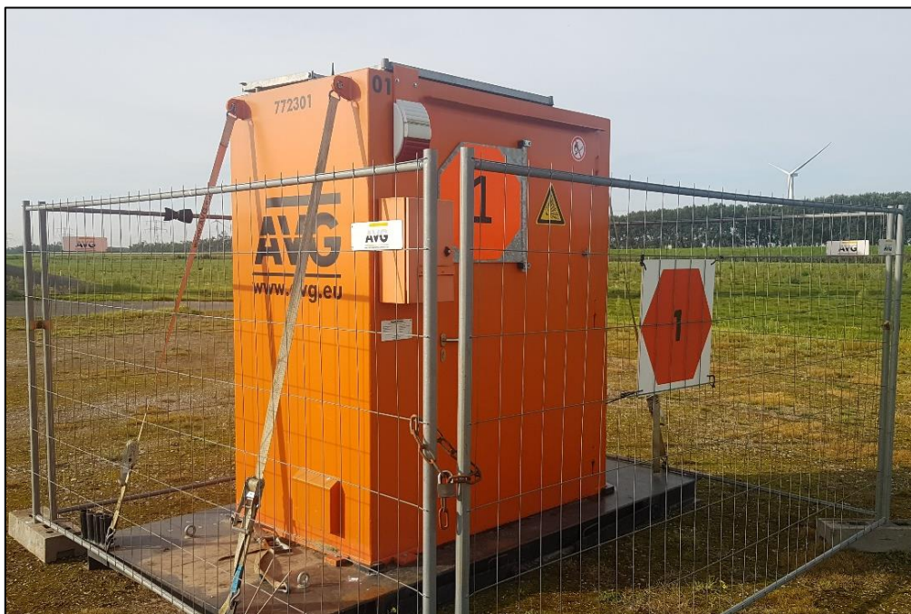
Afb.5 – Voorziening voor het Tijdelijk Veiligstellen van de Situatie (VTVS).
