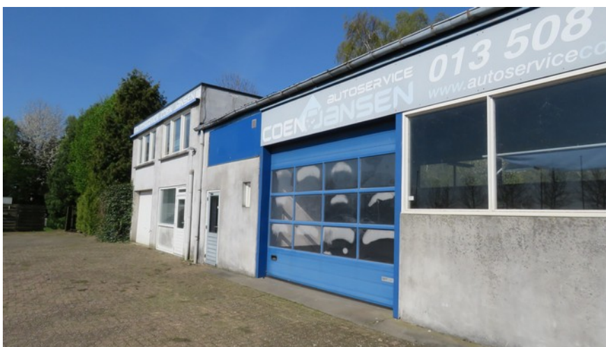
Afbeelding 18: Trespa beplating aan de onderzijde van de dakgoot constructie.
