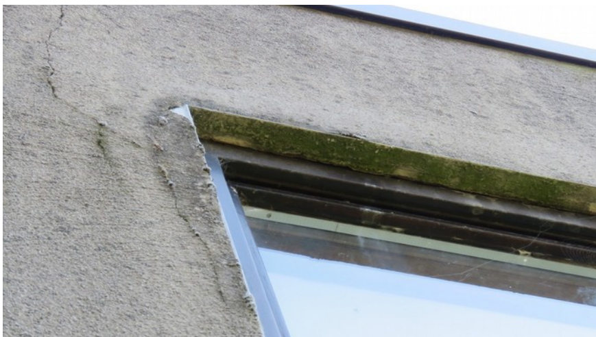
Afbeelding 14: raamkozijnen en daklijsten sluiten nauw op de gevel van het woonhuis.
