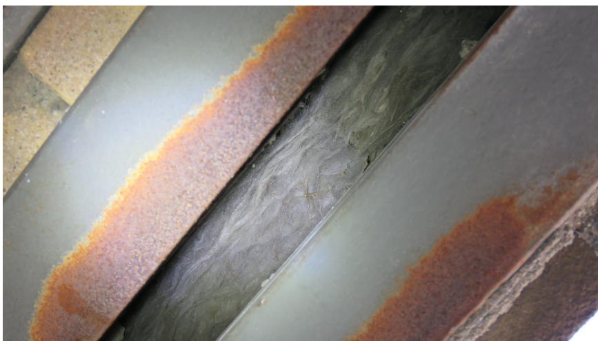
Afbeelding 21: Wanneer de garagedeur aan de achterzijde van de showroom open is, is de glaswol muurvulling zichtbaar.
