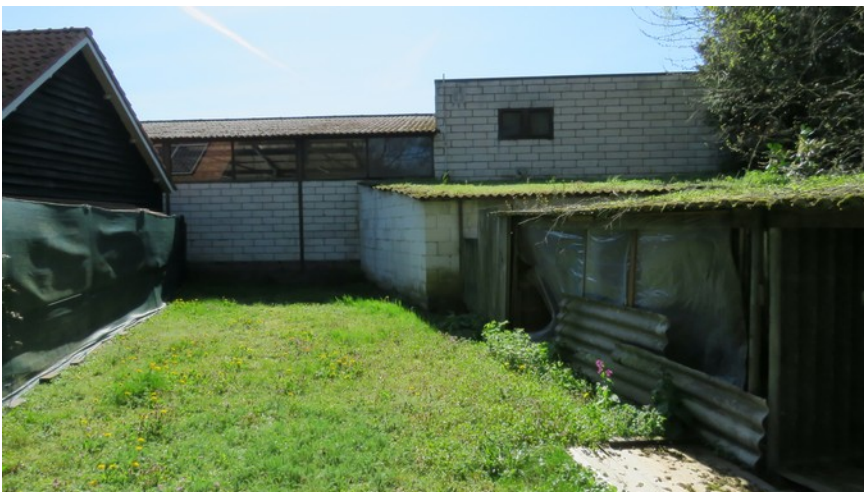
Afbeelding 9: De houten schuur (links) met het dakvlak wat geschikt is voor huismussen. De zuidwestgevel wordt momenteel geblokkeerd door de garage.
