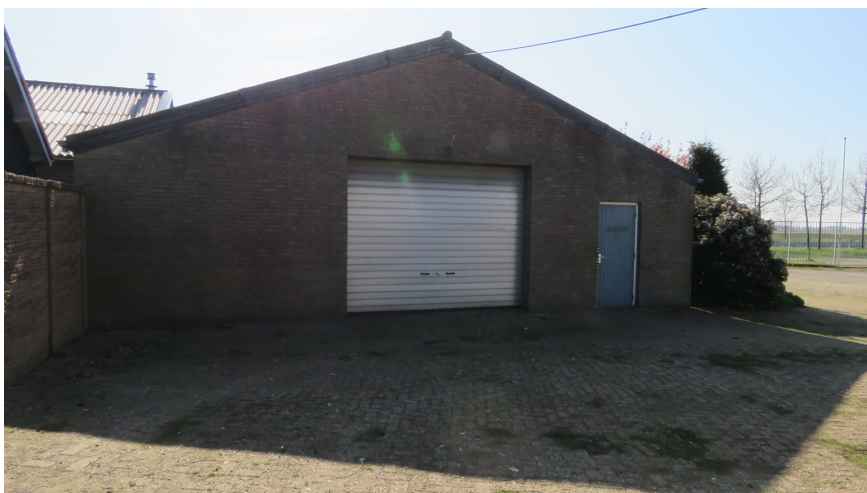
Afbeelding 22: Zicht op de achtergevel van de showroom, met de garagedeur en de strak aansluitende dakbekleding.
