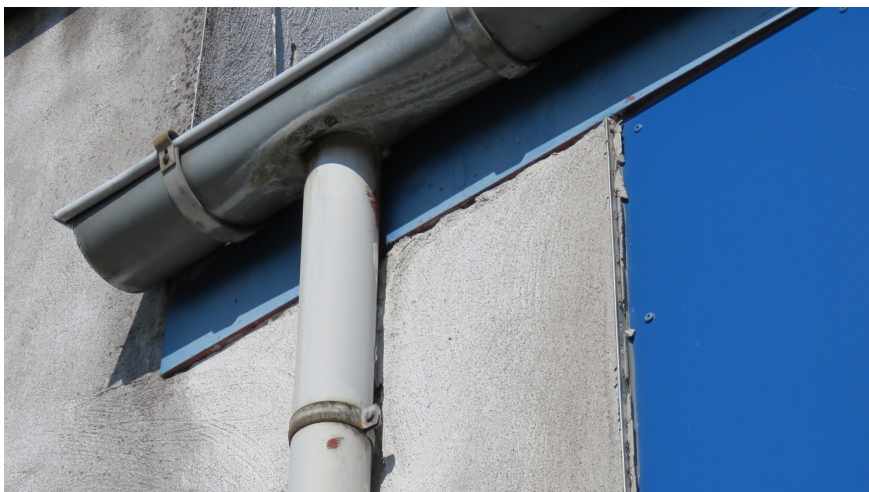
Afbeelding 17: De gladde trespa beplating sluit strak aan op de gevel, hier zijn geen vleermuisverblijfplaatsen aanwezig.
