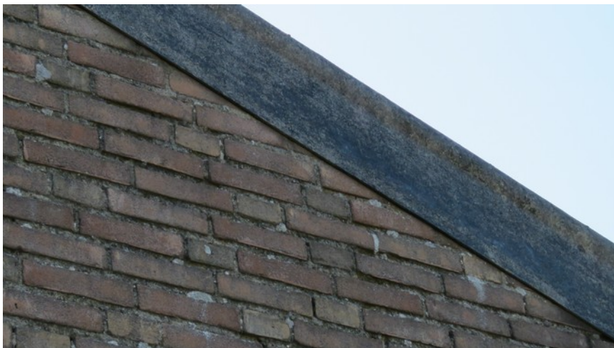
Afbeelding 20: Het dakleer sluit nauw aan op de gevel van de showroom en overlapt een aanzienlijk deel van de kopse gevel.
