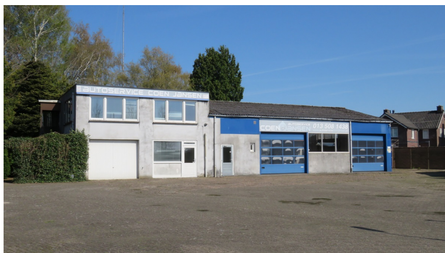
Afbeelding 2: Bebouwing op het terrein: een voormalige garage met woning.
