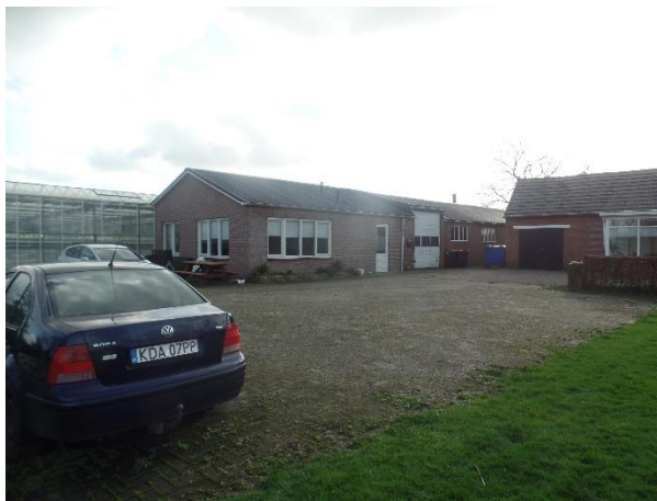
Zicht op schuur
