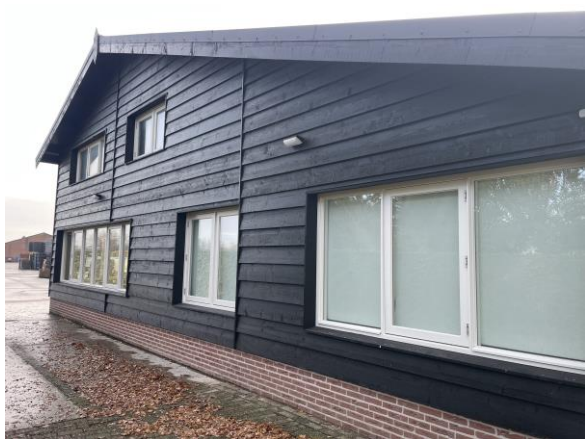
Geen kieren in de houten gevelbekleding van de gebouwen.
