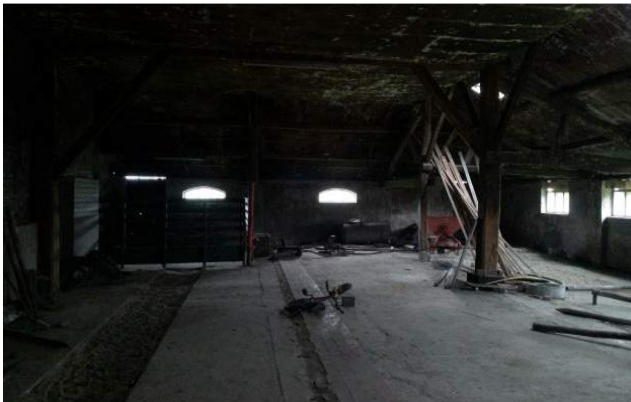
In gebouw 2 is naast de begane grond, ook een donkere onbereikbare zolder aanwezig. Hier kan de aanwezigheid van diverse vleermuizen en kerkuil niet worden uitgesloten vanwege de vele geschikte openingen. Foto: M. de Vries | Ecoresult B.V.
