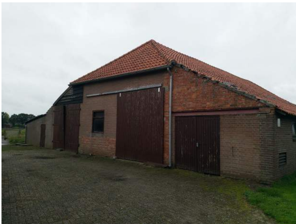
Afbeelding 3. Gebouw 2 staat achter op het plangebied. Foto: M. de Vries | Ecoresult B.V.
