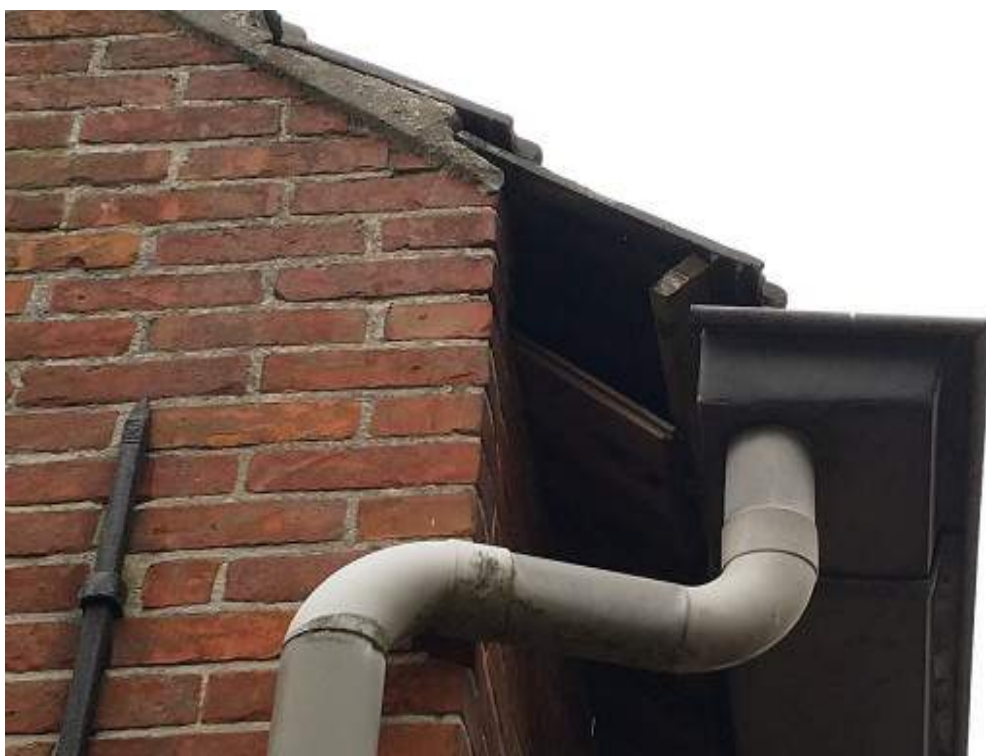
Op diverse plaatsen zijn openingen in het westelijke deel van gebouw 3 voor bijv. huismussen om tussen de dakpannen en het isolatiemateriaal te komen. Foto: M. de Vries | Ecoresult B.V.
