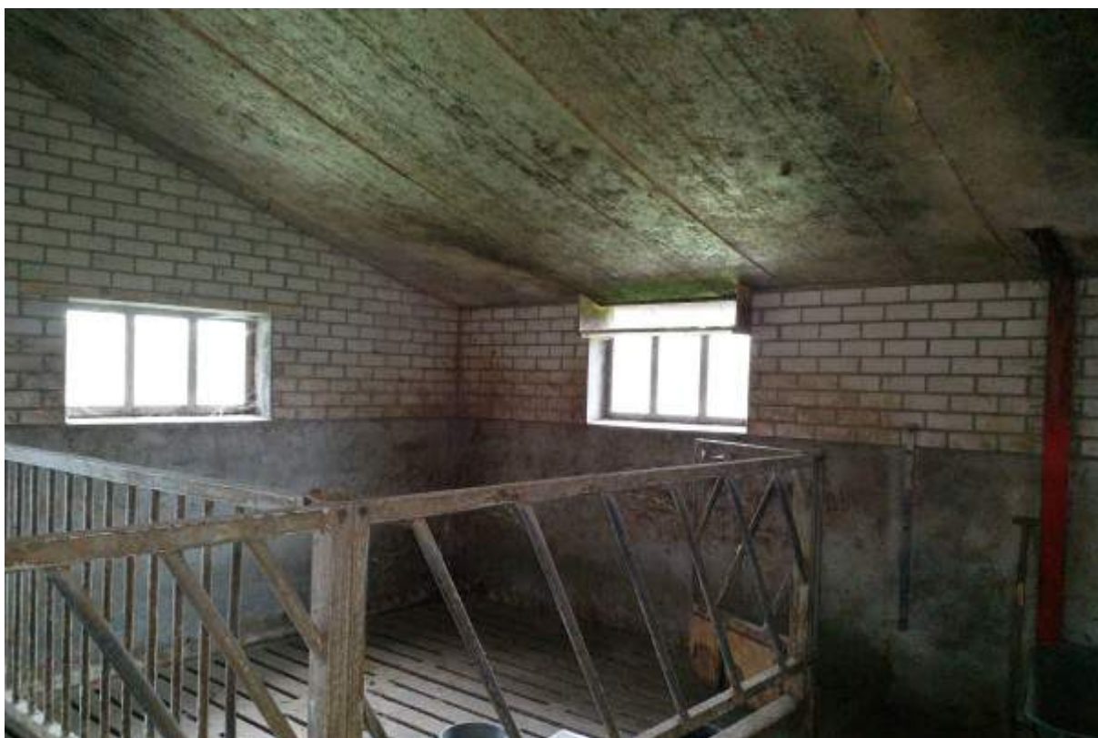
In gebouw 1 liggen isolatieplaten onder de dakplaten met een ruimte ertussen, die enkel bereikbaar is van de buiten. Foto: M. de Vries | Ecoresult B.V.
