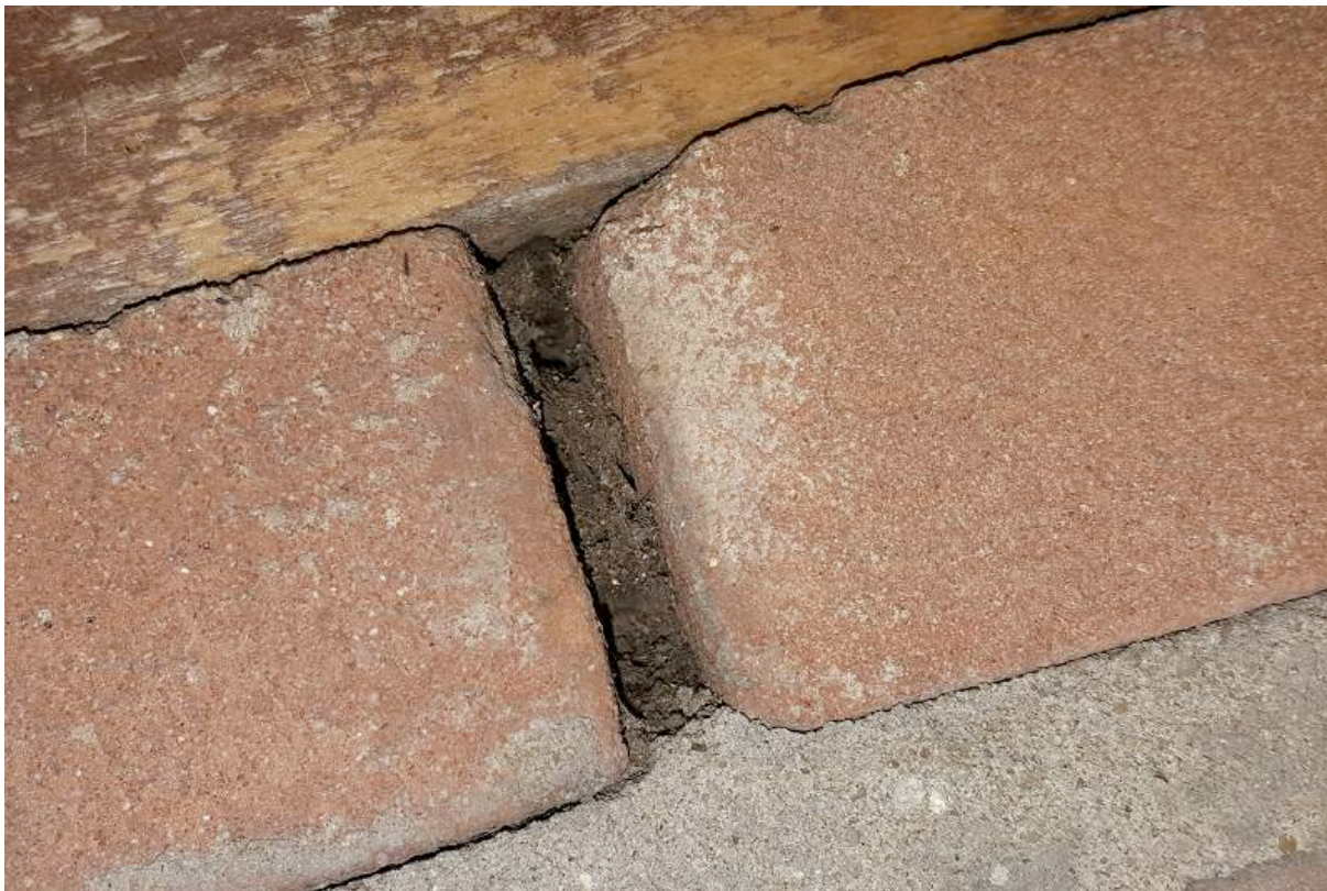
Afbeelding 3: Open stootvoeg vol met spinnenrag. Foto: B. Verhoeven / Ecoresult B.V.
