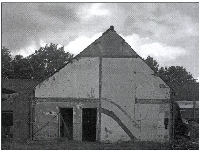
te slopen boerderijwoning
