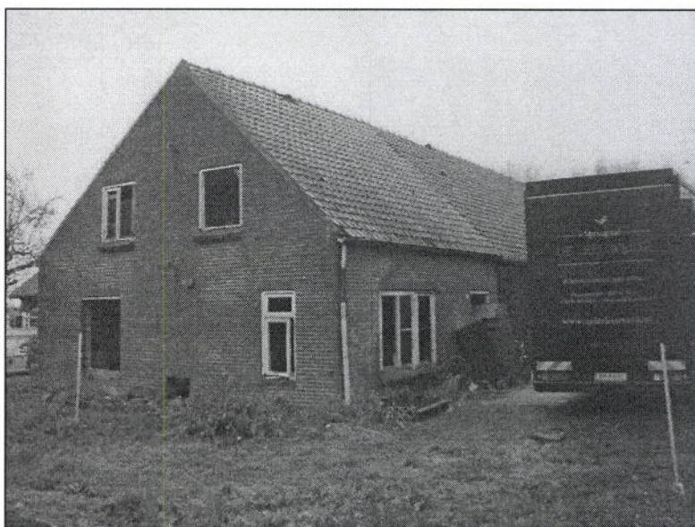
te slopen boerderijwoning
