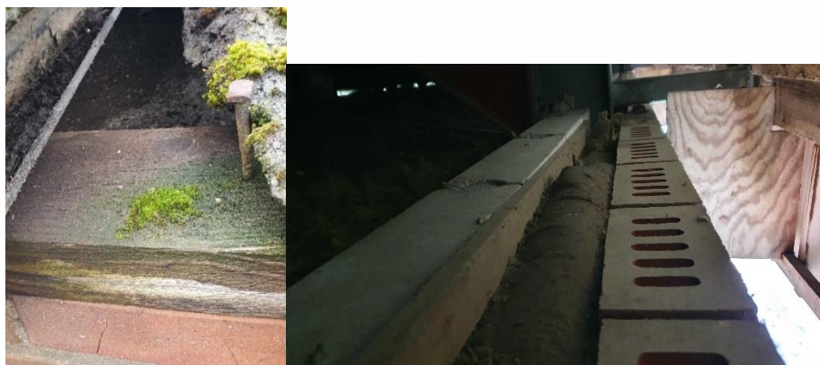
Figuur 4.4.2. De lange gevelzijdes van opstallen 1 t/m 3 bevatten een muurplaat (links) en de spouw in de lange gevelzijde van opstal 4 is opgevuld met een steen- of glaswol (rechts). Vleermuizen kunnen hier dus niet in de spouw kruipen.
