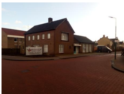
Aanzicht onderzoekslocatie vanaf de Willibrordstraat.
