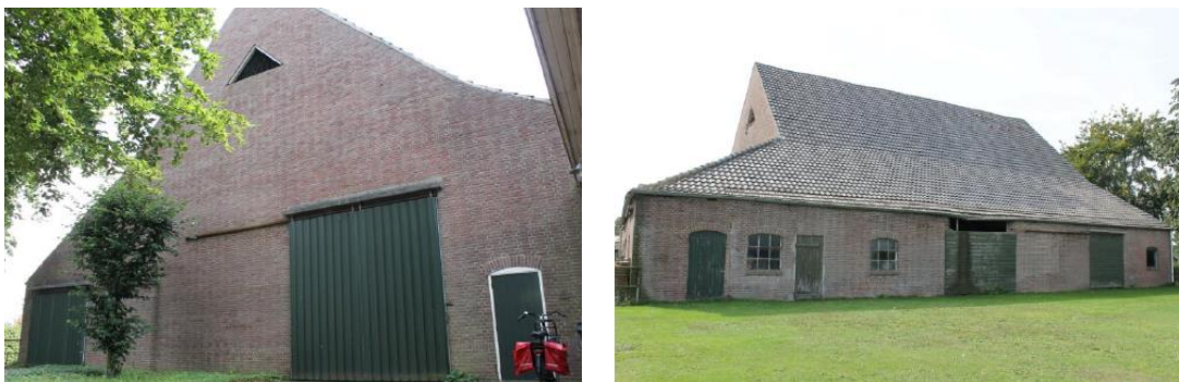
Figuur 4 Voor- en zijgevel van de schuur
