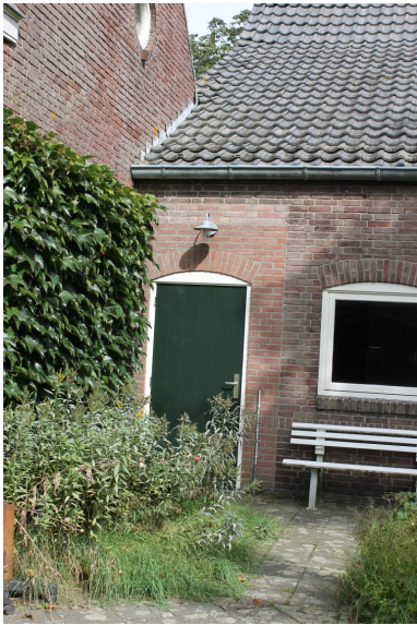
Vernieuwd metselwerk met nieuwe deur en kozijn
