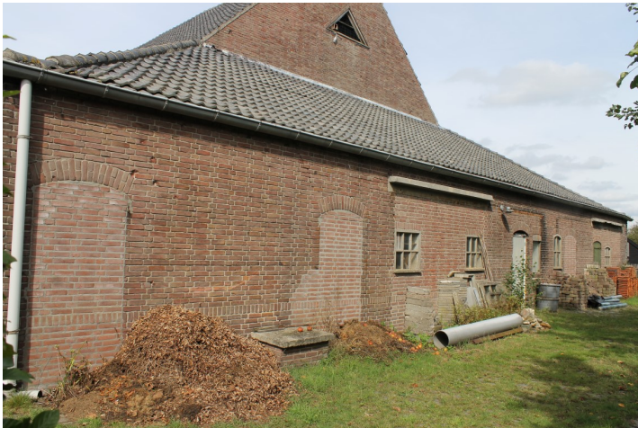
Achtergevel schuur met links dichtgezette loopdeuren en inboetwerk naast de linker loopdeur
