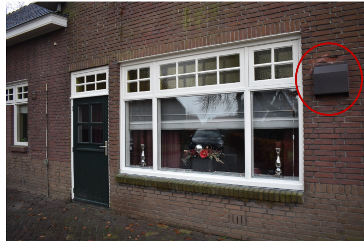
Venster met daarnaast vernieuwde deur. Rechts van het venster is een suskast aanwezig (cirkel).
