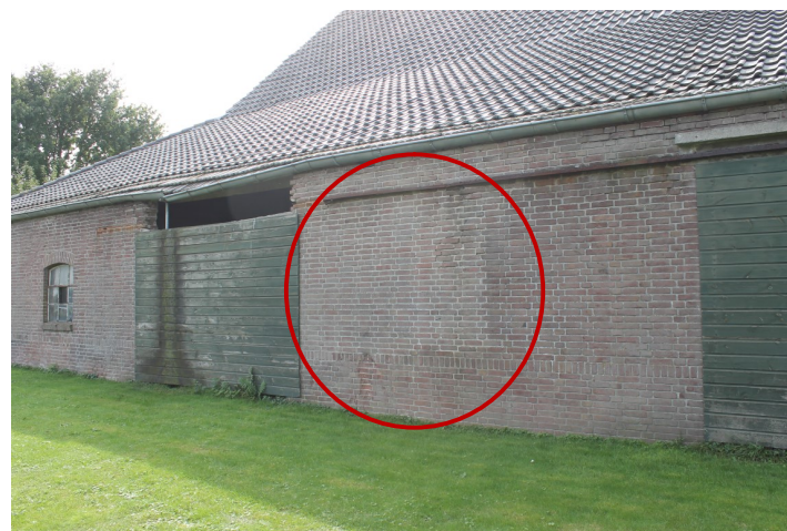
Inboetwerk in de cirkel met links de vergrote opening
