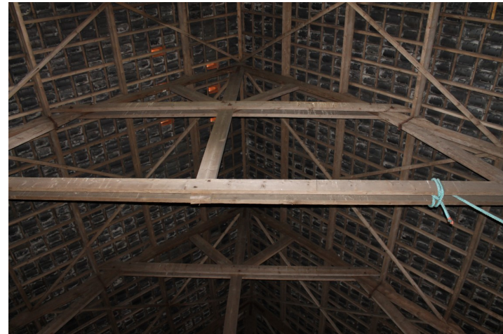
Variant op het verbeterde Hollandse spant
