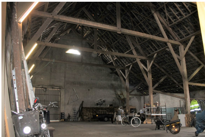
De grote open schuur richting voorgevel
