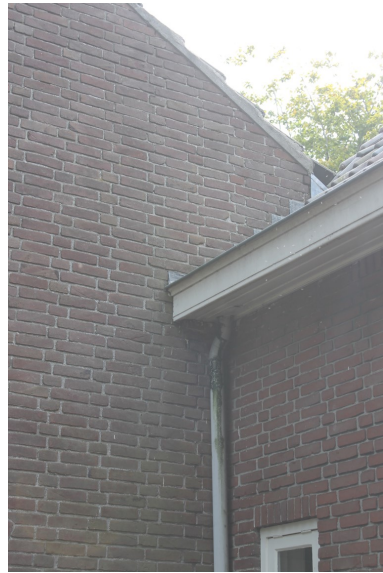
Aansluiting tussenlid en cementzoom langs dakrand
