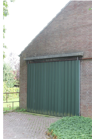
Kleinere vernieuwde schuifdeur aan oorspronkelijke rails en betonlatei
