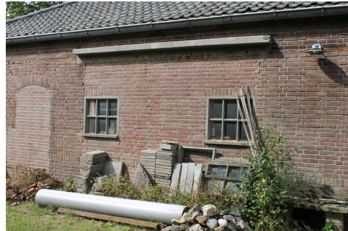
Dichtgezette schuifdeur opening met betonvensters uit de jaren '50/'60
