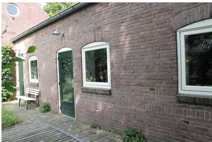
De rechterzijgevel van de schuur met vernieuwde vensters en deuren
