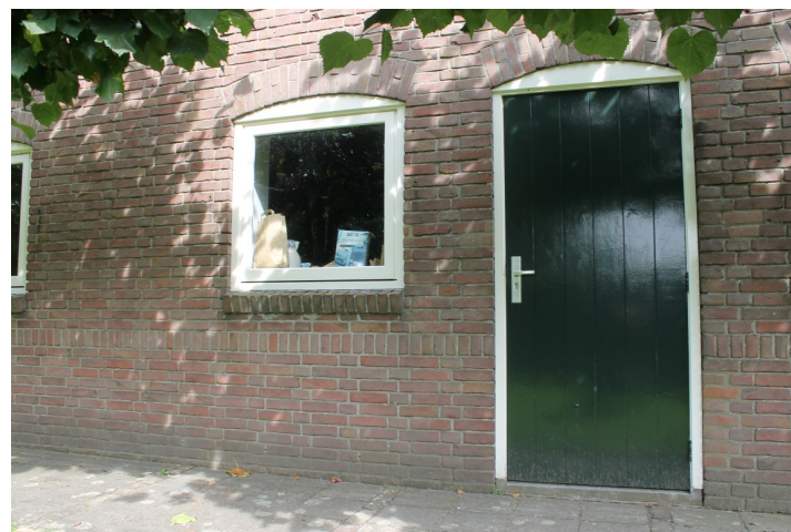
Vernieuwd kozijn, deur en venster in oorspronkelijke openingen
