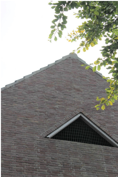
Driehoekige opening in topgevel
