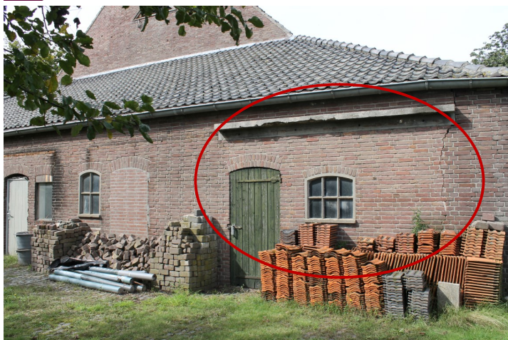
In de cirkel de verwijderde schuifdeur met dichtzetting in sparing
