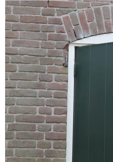
Oorspronkelijke duim, vernieuwd kozijn
