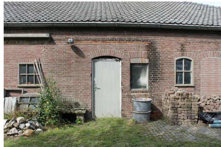
Vernieuwde loopdeur met rechts twee vernieuwde vensters en dichtgezette loopdeur
