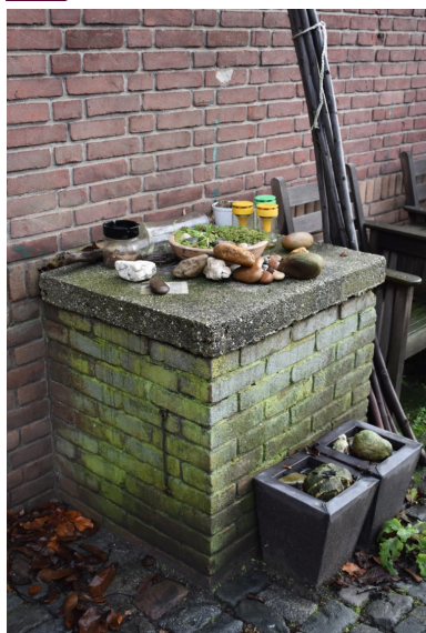
Gemetselde waterput tegen zijgevel
