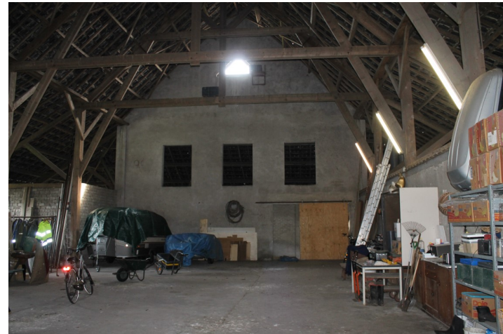
Constructie schuur richting achtergevel
