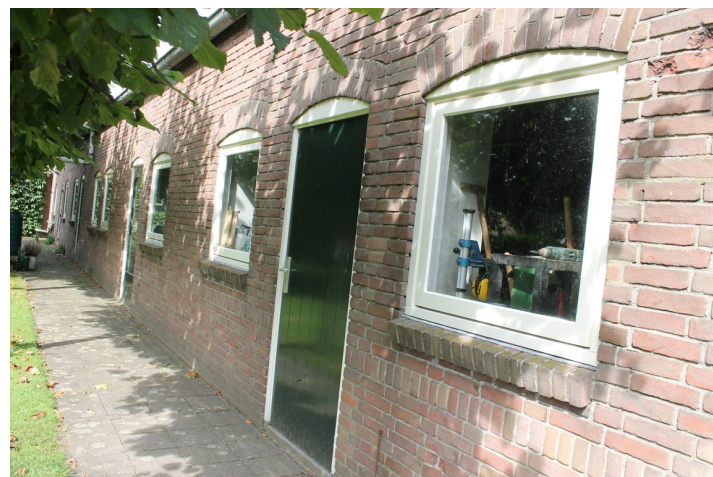
Achterste gedeelte rechterzijgevel
