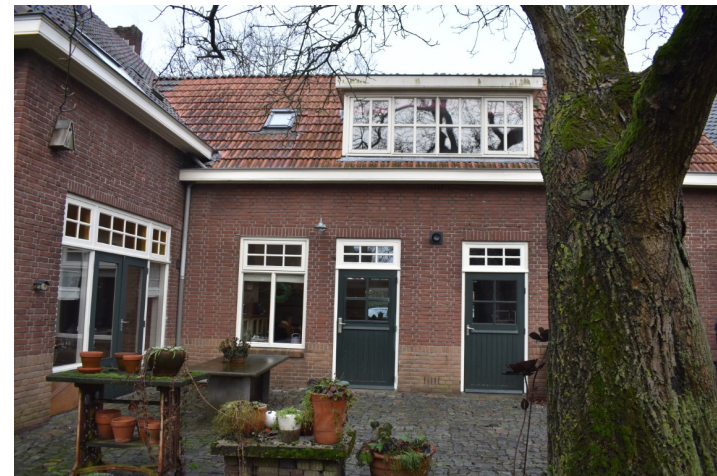
Rechterzijgevel met rechts volledig oorspronkelijk kozijn, bovenlichten loopdeur
