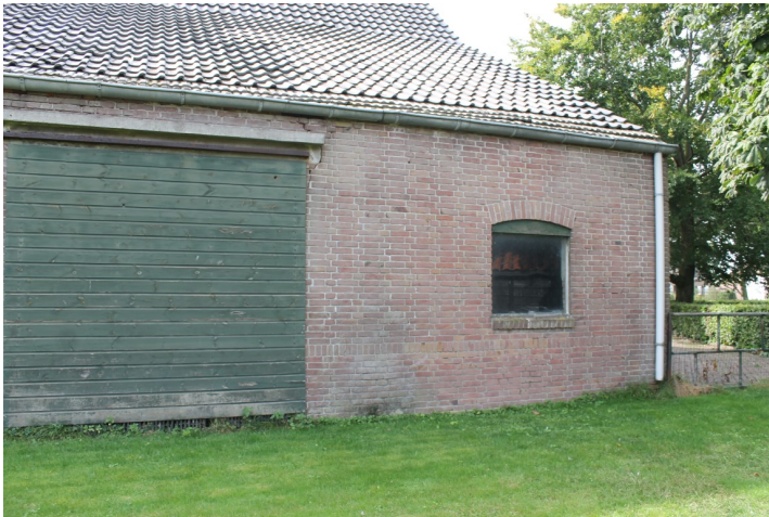
Vernieuwd venster in sparing uit bouwtijd
