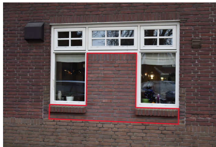
Gereconstrueerd venster en metselwerk op basis van oorspronkelijke bouwtekening (met inboetwerk in rood kader)
