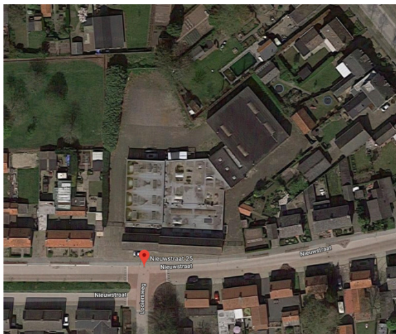
Afbeelding 1: luchtfoto bestaande terrein
