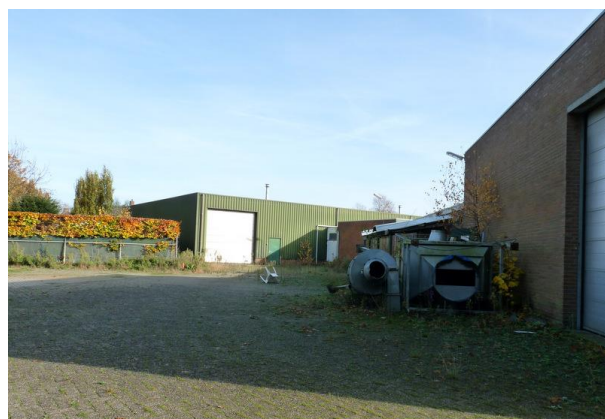
Figuur 7. De bestraatte parkeerruimte achter het Gerla-gebouw. Op de achtergrond de bedrijfshallen, die momenteel zo goed als leeg staan. Foto genomen richting het oosten.
