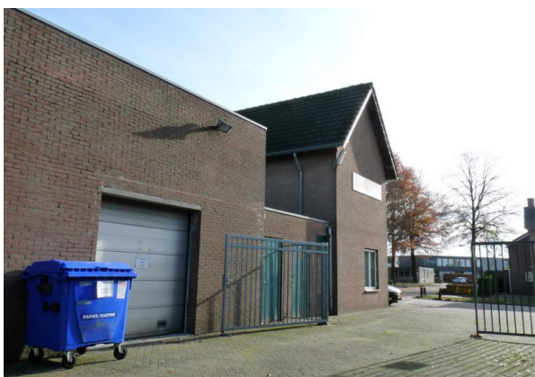
Figuur 6. Westzijde van het Gerla-gebouw, met zicht op de kantoorruimte en een van de bedrijfshallen. Foto genomen richting het zuiden.
