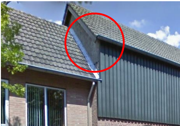
Figuur 16. Dakrand van de oude klompenfabriek (links) en de kantoorruimte (rechts). Op de hoek, en tussen het houtbeschot zitten openingen die geschikt zijn voor vleermuizen (rode cirkel).
