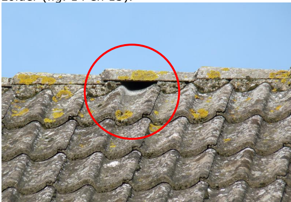
Figuur 20. Detail van foto 19. Openingen in de dakrand van het kantoor, die mogelijk toegang geven tot de ruimtes onder de dakpannen, en mogelijk geschikt voor huismus.
