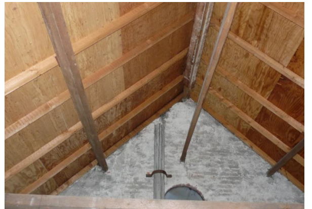
Figuur 15. Interieur van de zolder van de oude klompenfabriek.
