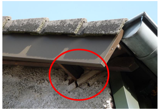
Figuur 17. Detail van de dakrand van de oude klompenfabriek (fig. 16), met opening bij de balk langs, die toegang geeft tot de zolder (fig. 14 en 15).
