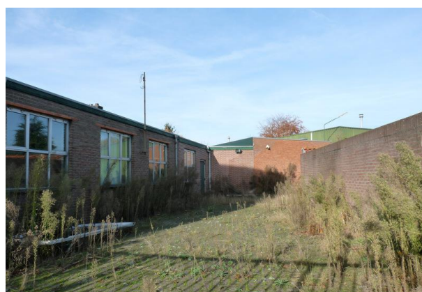
Figuur 9. De bestraatte parkeerruimte aan de oostzijde van het Gerla-gebouw. Op de achtergrond de bedrijfshallen, die momenteel zo goed als leeg staan. Foto genomen richting het noorden.
