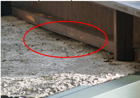
Figuur 18. Detail van de dakrand van de oude klompenfabriek (fig.16), met opening bij het dakbeschot langs, die toegang geeft tot de zolder (fig. 14 en 15).
