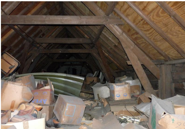
Figuur 14. Interieur van de zolder van de oude klompenfabriek.
