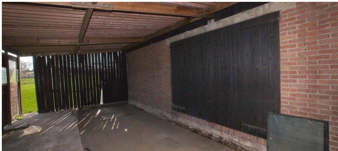
Figuur 18: Binnenzijde bijsschuur.
