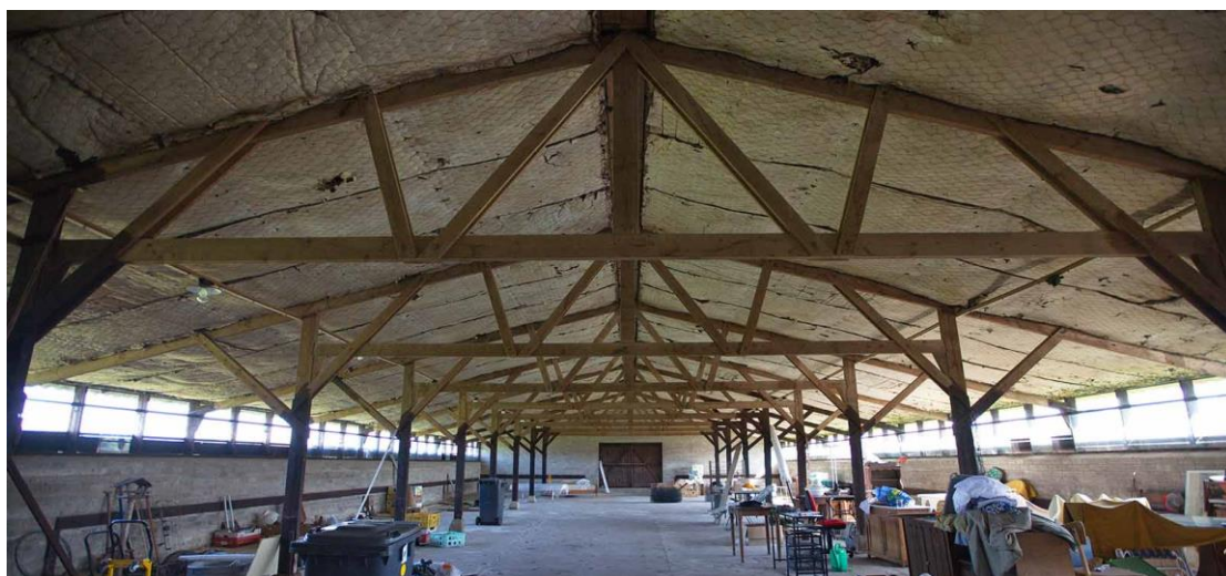
Figuur 15: Binnenzijde Kippenschuur met dakisolatie.
