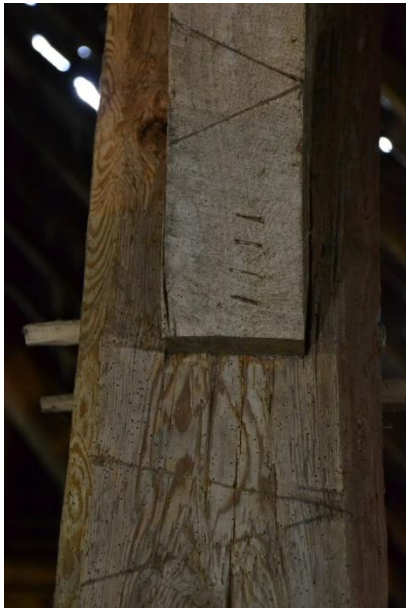
Telmerken III en V aan de rechterzijde van gebintstijl 3b.
