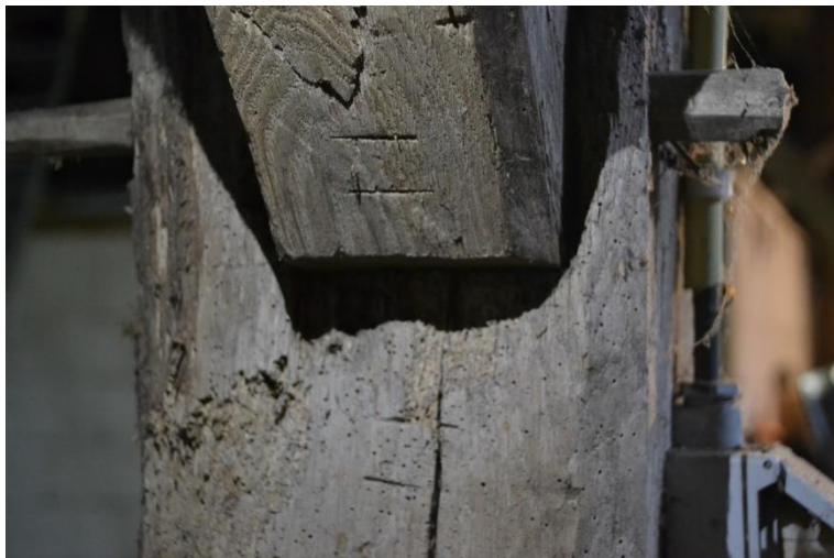
Telmerken II op de gebintstijl en linkerschoor.
