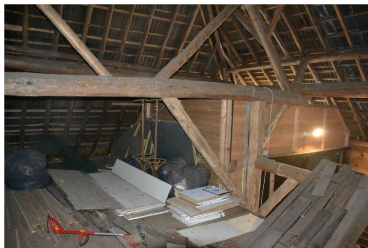
Bovenzijde van gebint 1a met daarop het spant.
