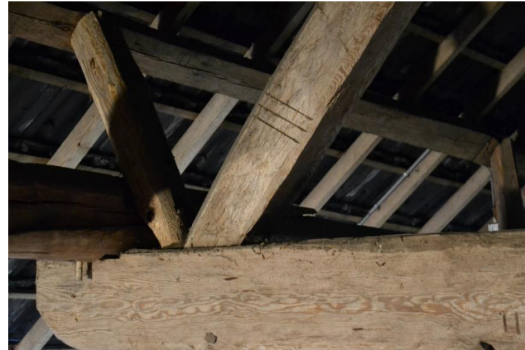
Spantbeen 2a met gezaagd telmerk ///.
