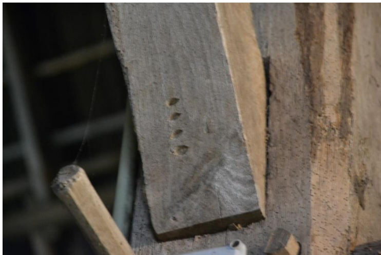
4 Gegutste ovaaltjes op het korbeel aan de deelszijde.
