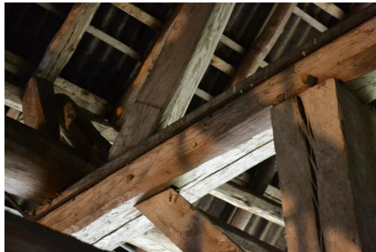
Gezaagd telmerk I op het spantbeen 4a.
