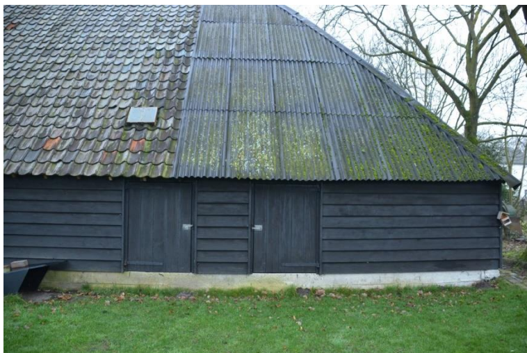
Houten loopdeuren in de achtergevel.
