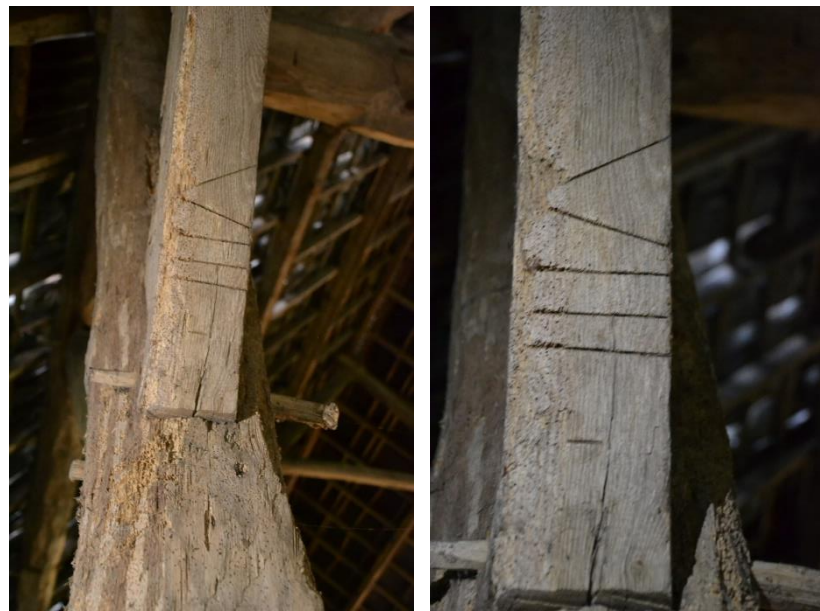
Telmerken I en '\\\\\' links op gebintstijl 4b en op de linkerschoor.
