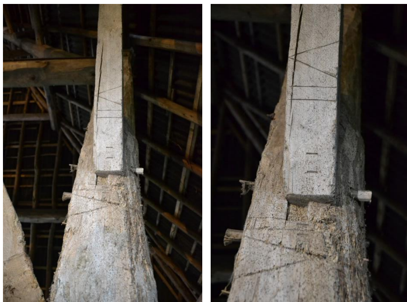
Telmerken II en \\\\ op de rechterzijde van gebintstijl 4b en de rechterschoor.
