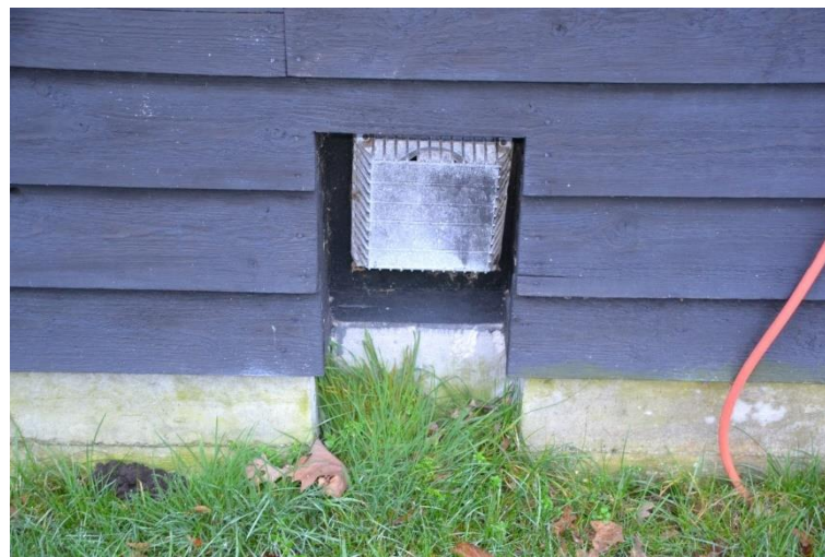
Opening in de plint van de achtergevel met luchtafvoer.
