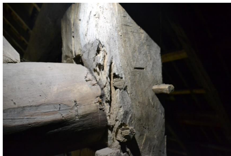
Dezelfde onderdelen als in de vorige afbeelding, maar met duidelijk het telmerk op de gebintstijl.
