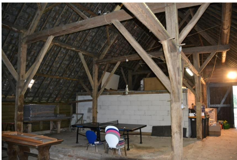
Interieur van de schuur naar de zuidzijde gezien.
