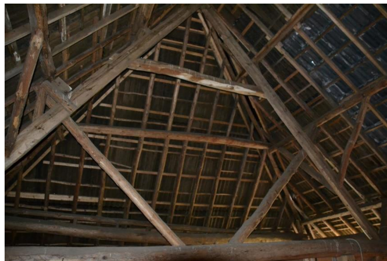
Spant 1 verstevigd met windverbanden.
