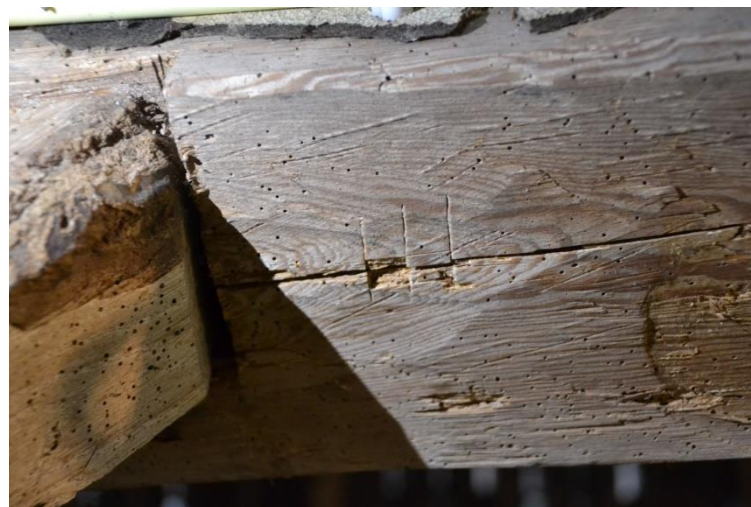
Gesneden telmerk III op de gebintkoppelbalk.
