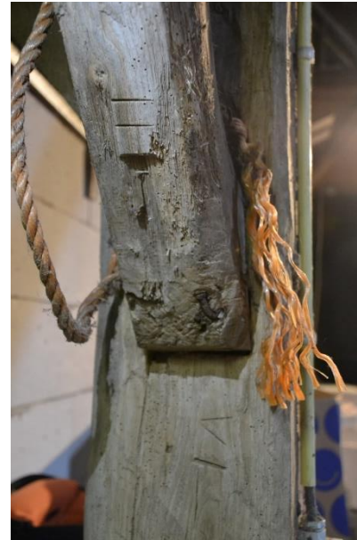
Telmerk VI op de gebintstijl en telmerk II op de schoor.
