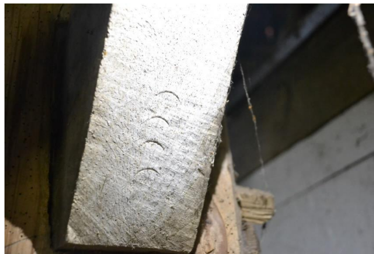
De vier halve maantjes op het korbeel aan de middenbeukzijde.
