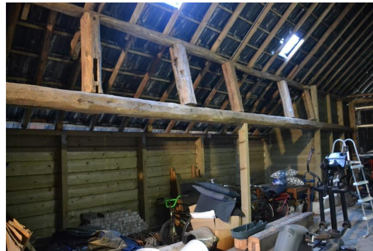
Hulpconstructie met gebruik van hergebruikte balken/stijlen.
