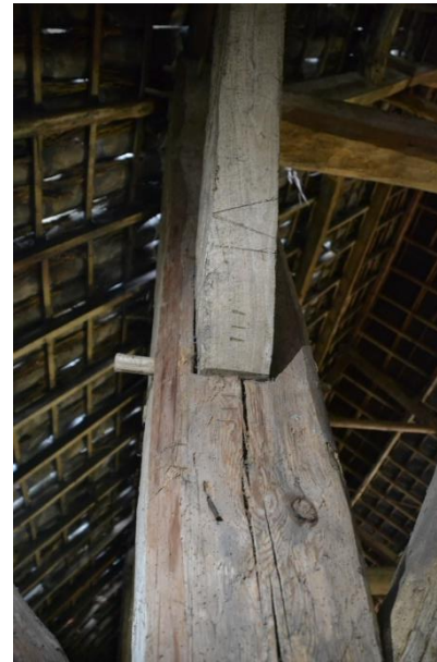
De telmerken III en \/' op de gebintstijl en linkerschoor.
