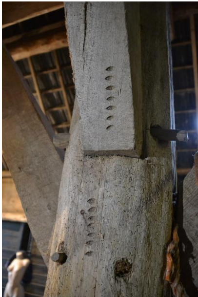
7 Gegutste ovaaltjes op de gebintstijl en het korbeel t.h.v. de deel.
