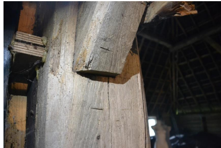
Telmerk I op gebintstijl en gebintkoppelbalkschoor.
