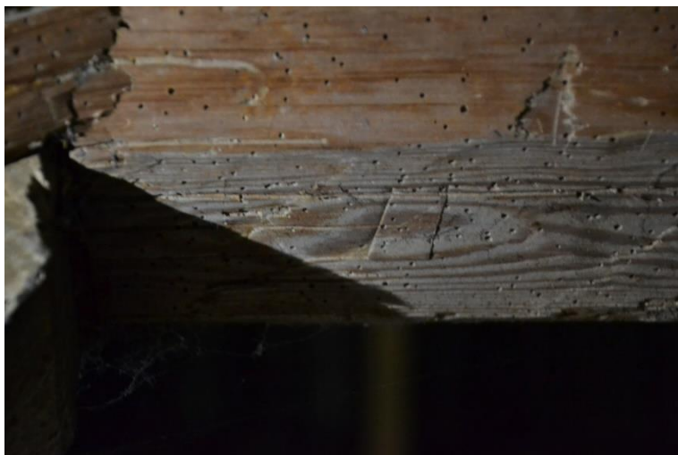
Gesneden telmerk II op de gebintkoppelbalk.
