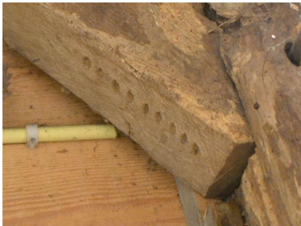
Detail telmerk op korbeel van 9 gegutste ovaaltjes.
