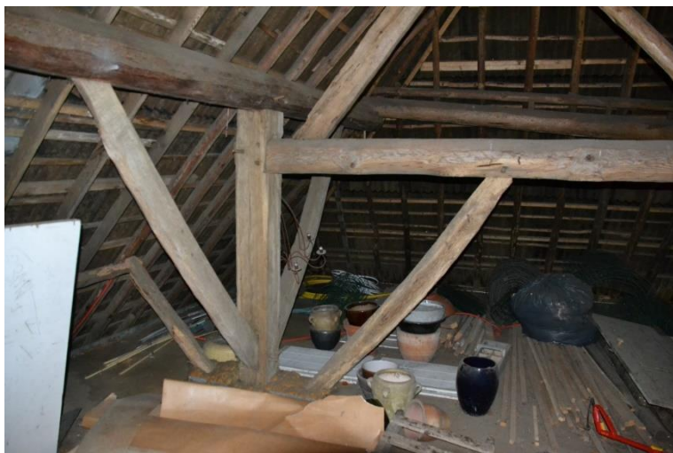
Aansluiting gebintstijl met ankerbalk en gebintplaat vanaf het noorden gezien.
