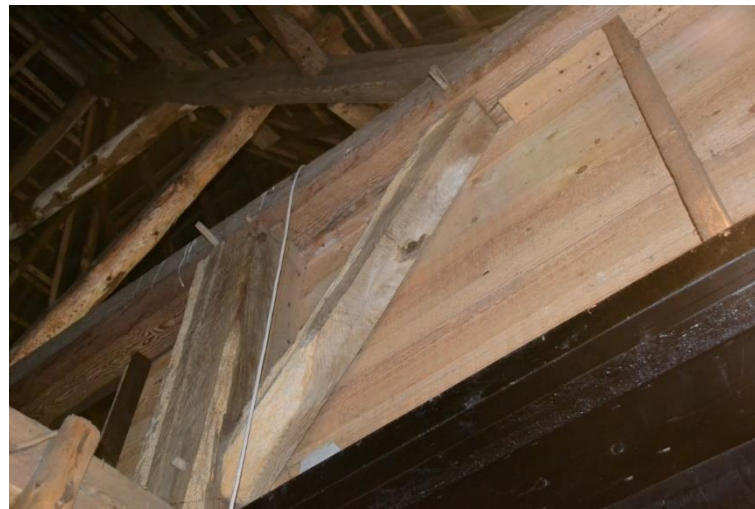
Korbeel dat gebintstijl aan de deelszijde met gebintbalk verbindt.
