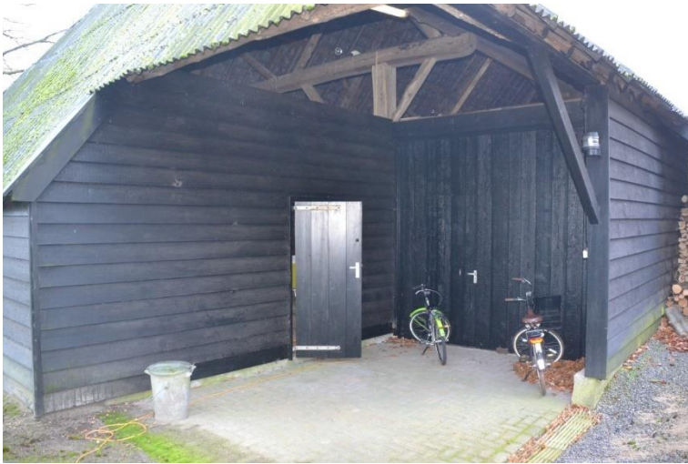
Uitsparing links in de voorgevel met houten loopdeur en deel- deuren.
