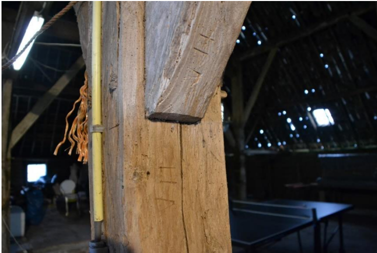
Telmerken VII op de gebintstijl en gebintkoppelbalkschoor.
