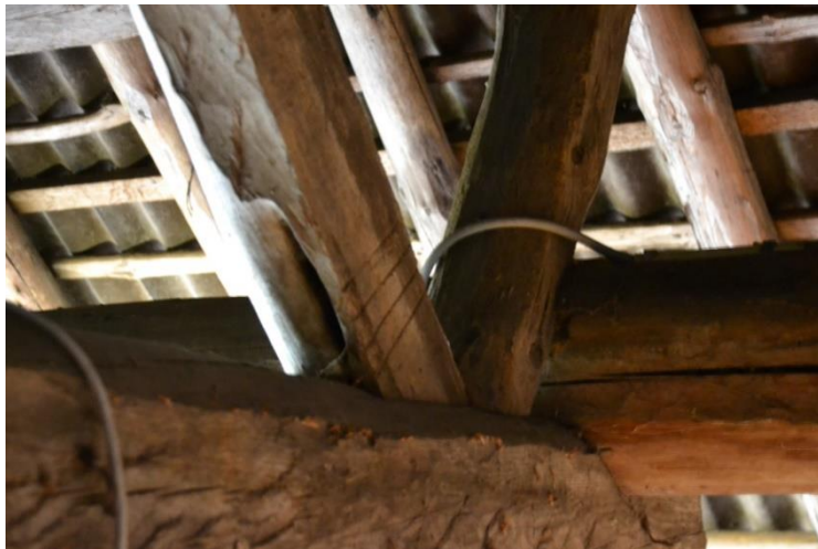
Gezaagd telmerk //// in spantbeen 1a.
