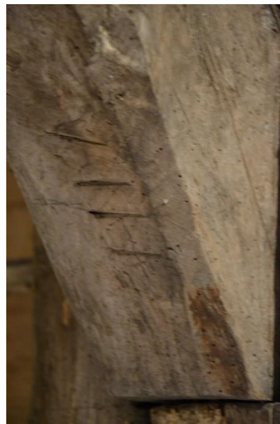
Detail van het telmerk op de gebintkoppelbalkschoor.
