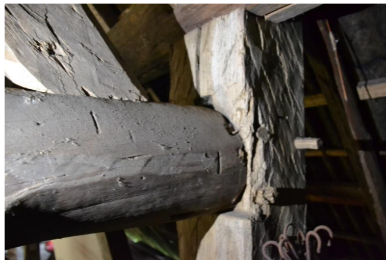
Gehakt telmerk 'I' aan de zuidzijde van het gebint op de gebintstijl en 2 keer op de ankerbalk.
