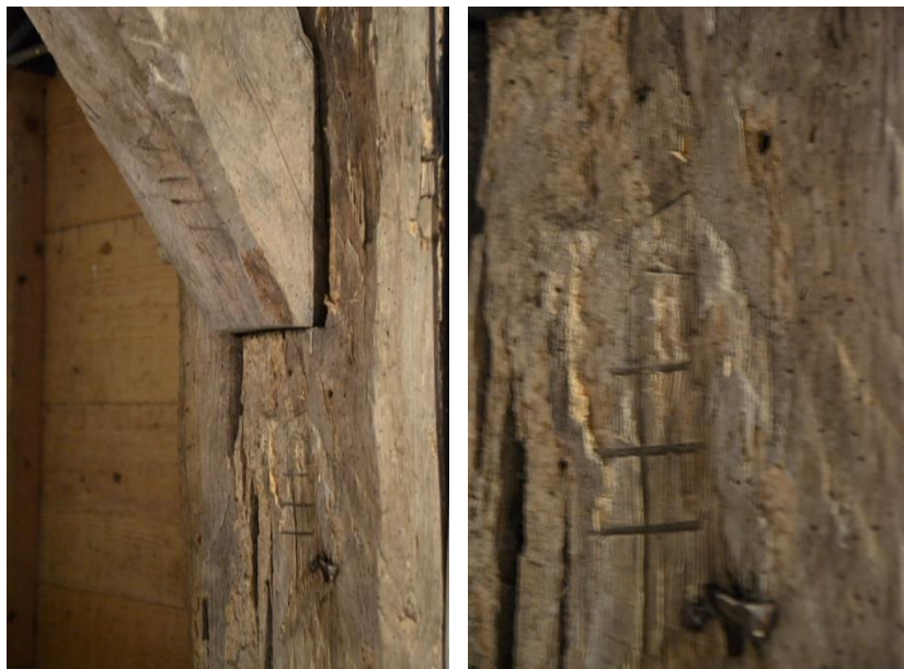
Links: gehakt telmerk VIII op zowel de gebintstijl als de gebintkoppelbalkschoor. Rechts: detail van het telmerk op de gebintstijl.
