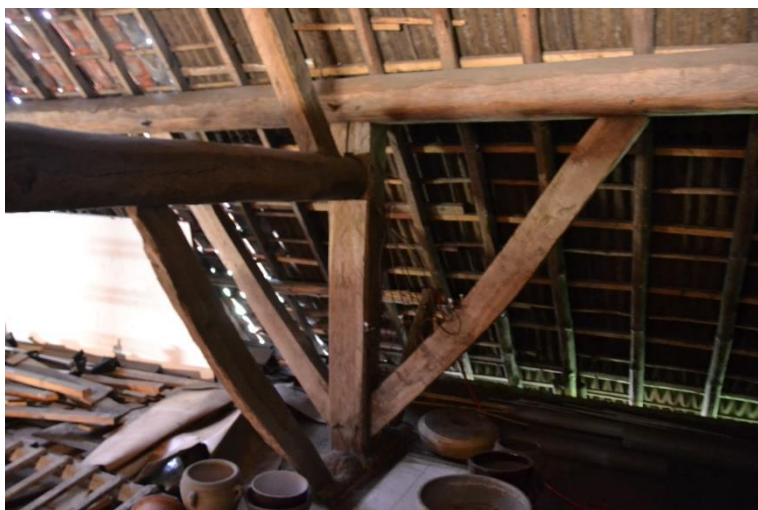
Aansluiting gebintstijl met ankerbalk en gebintplaat vanaf het zuidwesten gezien.
