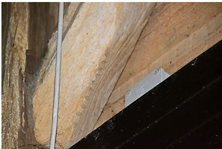
Detail telmerk op korbeel van 10 gegutste ovaaltjes.
