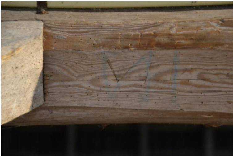
Telmerk VII op de gebintkoppelbalk.
