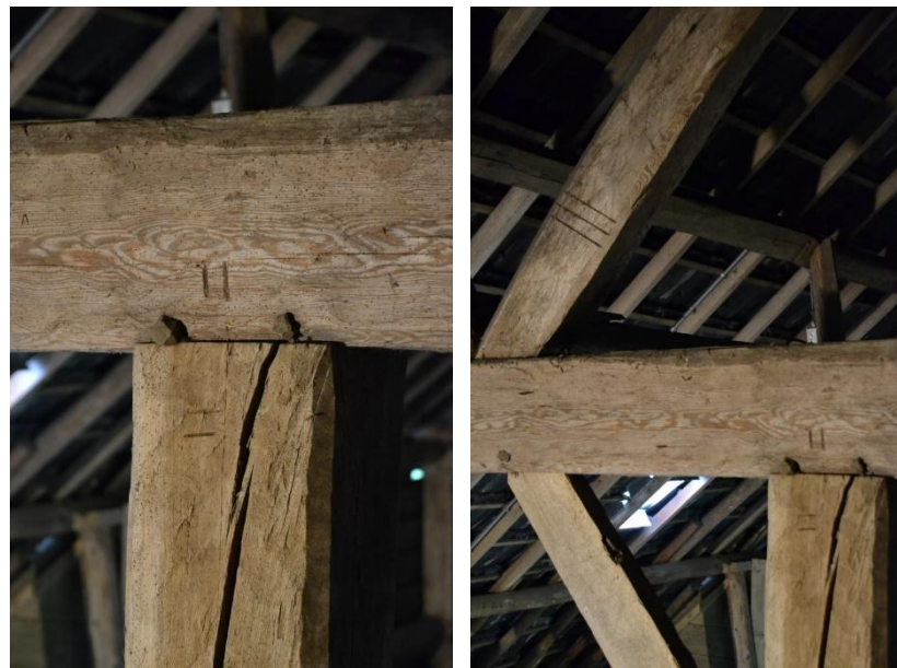
De telmerken II op het gebint en /// op het spantbeen.
