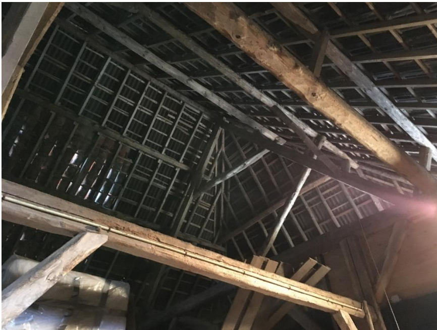
Figuur 5 | huidige dakconstructie
