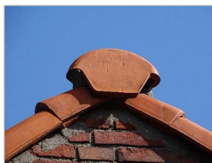
Foto 7: Dakrand (nok) bij huurwoningen.
