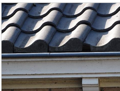
Foto 8: Dakrand en dakgoot bij schoolgebouw.
