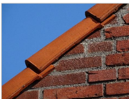
Foto 6: Dakrand bij huurwoningen.
