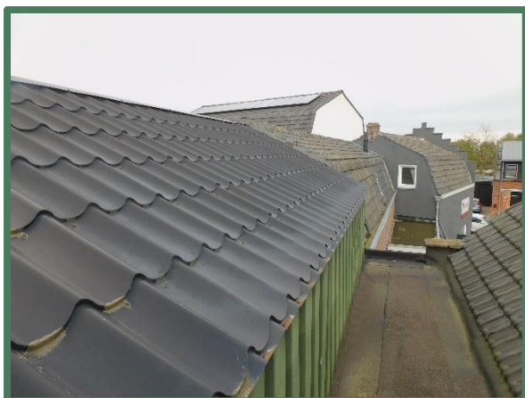
Overzicht met links damwand dak en plat dak te slopen. Rechts te behouden oude slachterij en achter de daken in mansardedakvorm van te behouden nummer 67.
