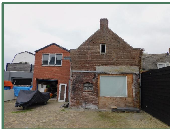
achterzijde te behouden deel met links te slopen deel
