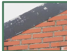
Aansluitende windveren te slopen deel
