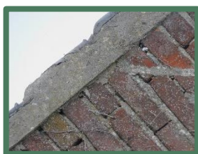
Aangesmeerde kopgevels oude slachterij
