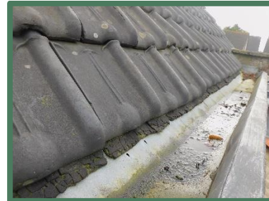
Onderste rij pannen in goot op zijmuur.
