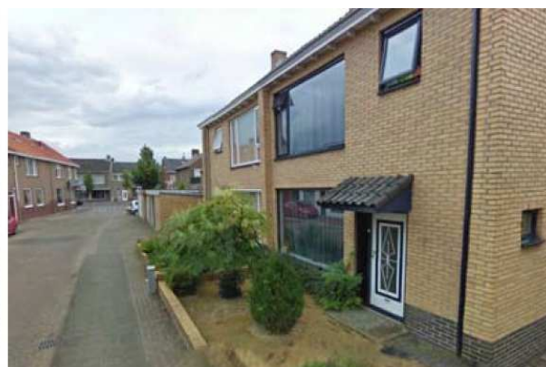
Foto 4. Woningen aan de Kapelstraat 1 en 3 met op de achtergrond de garageboxen aan de Kapelstraat
