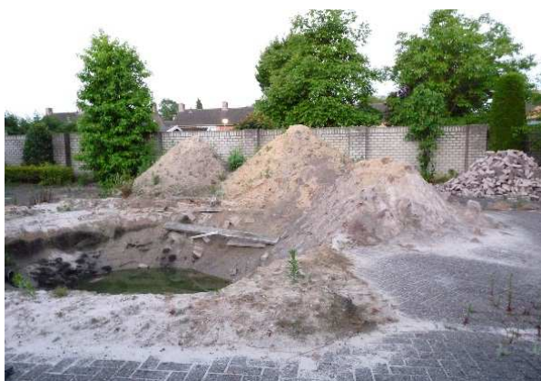
Foto 5. Uitgegraven gat op het binnenpleintje, met zandhopen er omheen en met water gevuld
