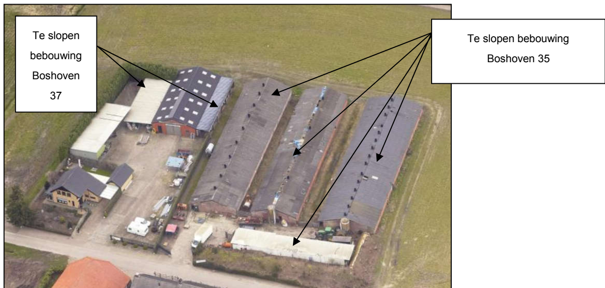
Figuur 11: Beeld met te slopen bebouwing binnen het plangebied
