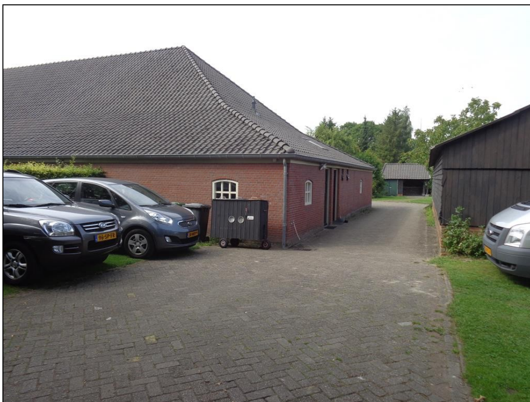
Afbeelding 5.3 Schuur met sanitaire voorzieningen en rechts kapschuur
