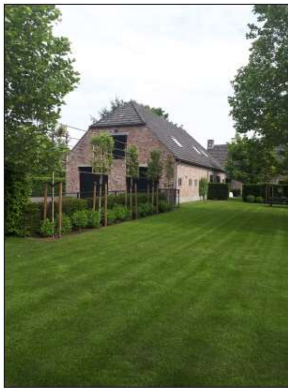
Fig. 8 Achterzijde bedrijfsgebouw + tuin
