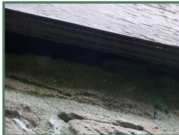
Ruimte onder de gevelbetimmering van de garage
