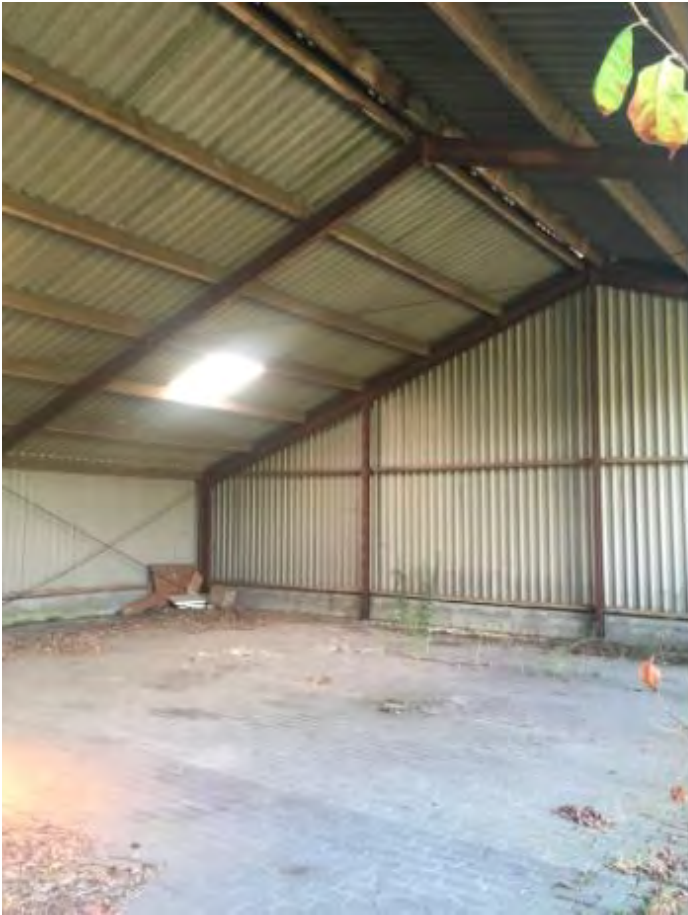
Foto 46 en 47: De openloods is gemaakt van staal / damwand, afgedekt met golfplaten.
