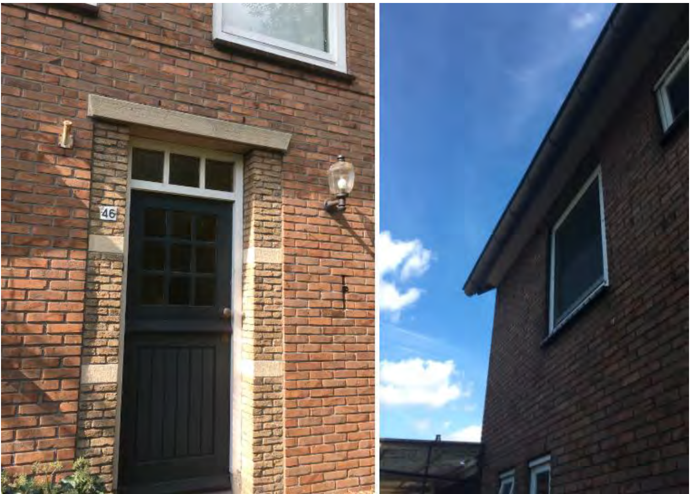
Foto 11 (links): Voordeur woning. Foto 12 (rechts): Kap is afgetimmerd
