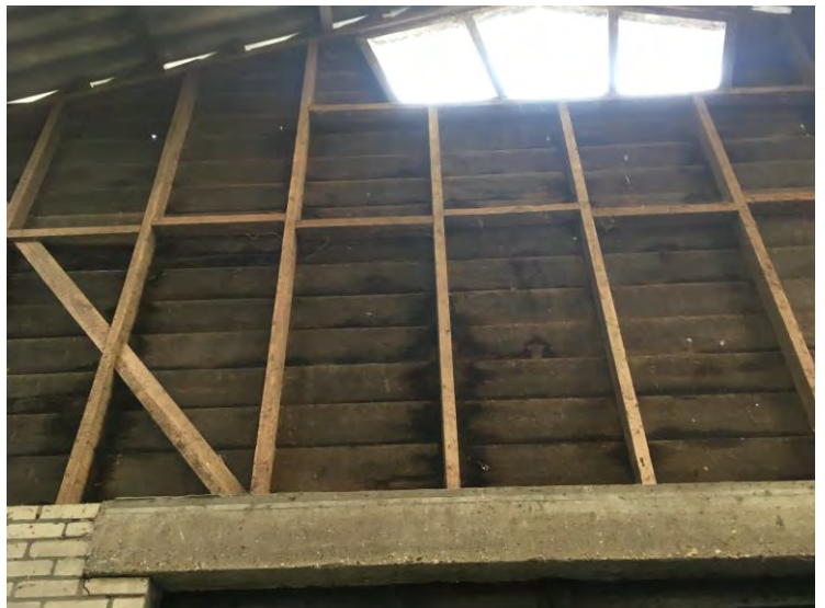
Foto 15 (boven): De topgevel van de stal aan de weg kant ( voorzijde stal 1) . Topgevel binnenzijde van de stal.
