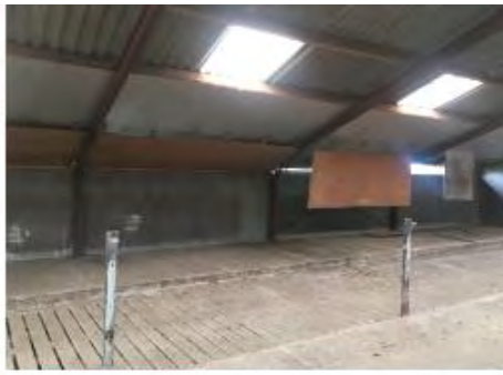
Foto 33, 34 en 35: In het jongvee gedeelte werden geen sporen aangetroffen
