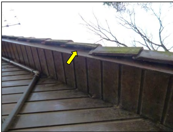
Figuur 9. De overhangende dakpannen.
