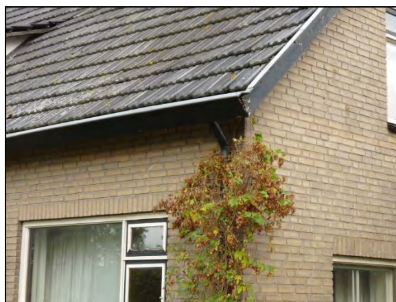
Figuur 10. Ruimte onder dakpannen bereikbaar voor huismus via dakgoot
