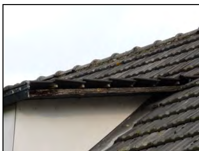
Figuur 12. Geschikte opening onder dakpannen voor vleermuizen
