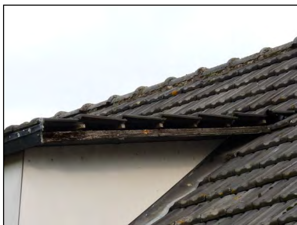
Figuur 9. Ruimte onder dakpannen geschikt voor huismus
