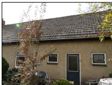
Figuur 7. Woonhuis op locatie 51
