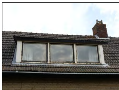
Figuur 11. Ruimte onder lood bij dak- raam geschikt voor vleermuizen
