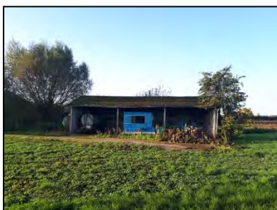
Figuur 6. Kapschuur aan de zuidkant van de onderzoekslocatie.
