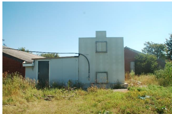
Afbeelding: luchtwasser
