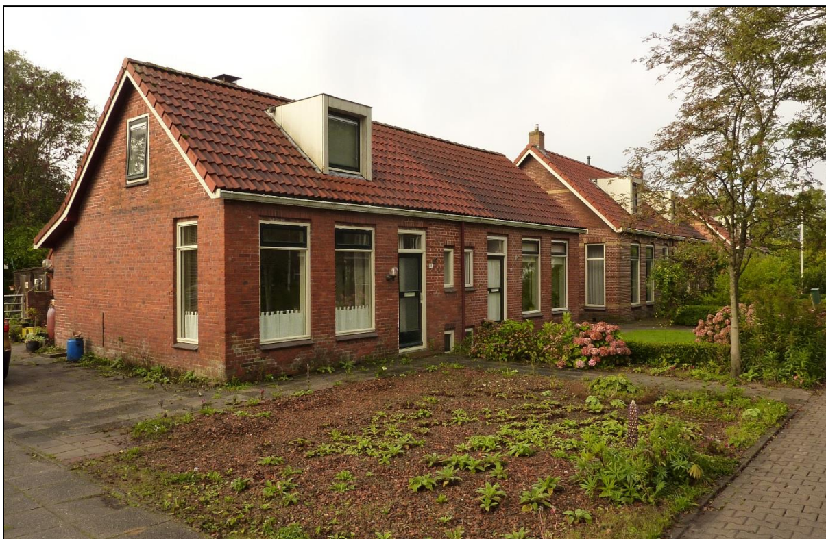
Figuur 1.4. Woningen aan de oneven zijde van de straat.
