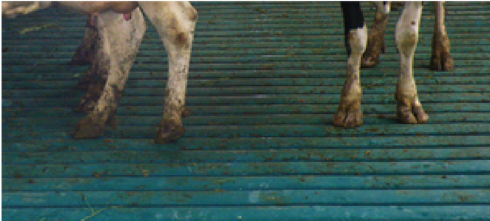
Figuur 60. Groene Vlag Roostervloer: emissiearm stalsysteem voor melkveehouderijen
