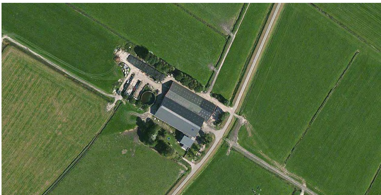
Luchtfoto van huidig erf (bron: Bingmaps)
