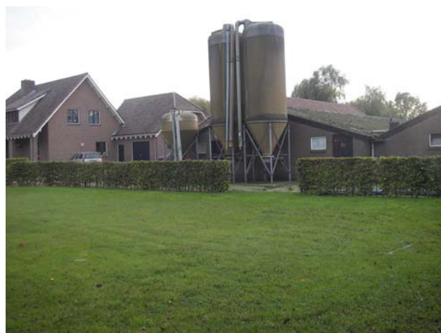
Figuur 13a: Het zuidwestelijke deel van het plangebied nabij boring 1, gezien in oostelijke richting.
