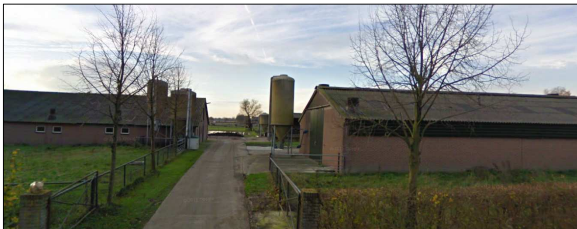
Figuur 3. Beeld van de te slopen bedrijfsgebouwen binnen het plangebied.
