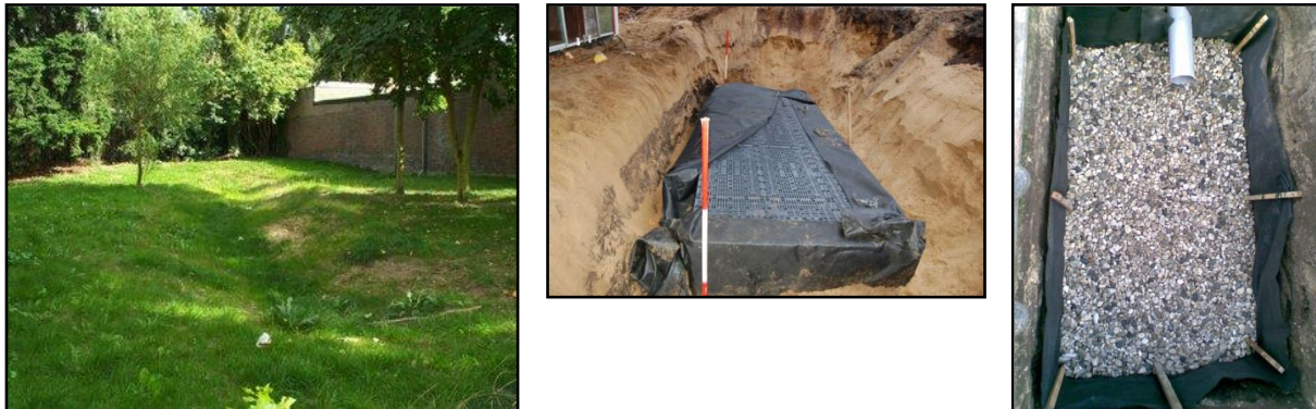
Figuur 27: Voorbeelden van infiltratiemogelijkheden
