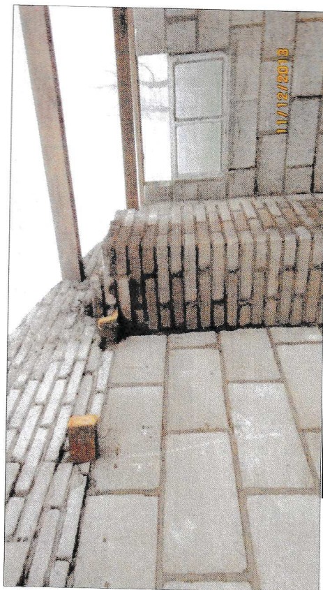
afbeelding 10: Schoorsteen waaruit ac-kanaal is verwijderd.
