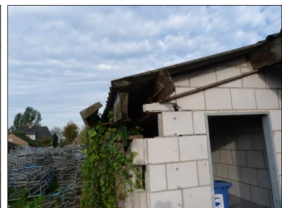
Figuur 24. Buitenmuur varkensschuren.
