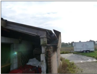
Figuur 25. Buitenmuur varkensschuren.
