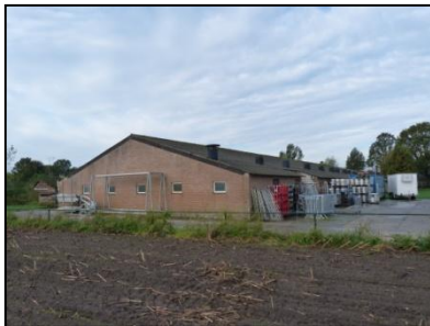
Figuur 3. De noordelijke voormalige varkensschuur.
