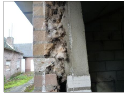
Figuur 27. Volledig gevulde spouwmuren.
