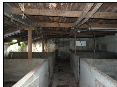
Figuur 8. Binnenzijde zuidelijke voormalige varkensschuur.
