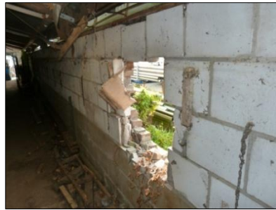
Figuur 26. Buitenmuur varkensschuren.
