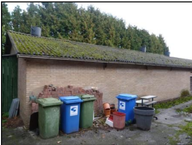
Figuur 12. Westelijke deel van de noordelijke voormalige varkensstal.
