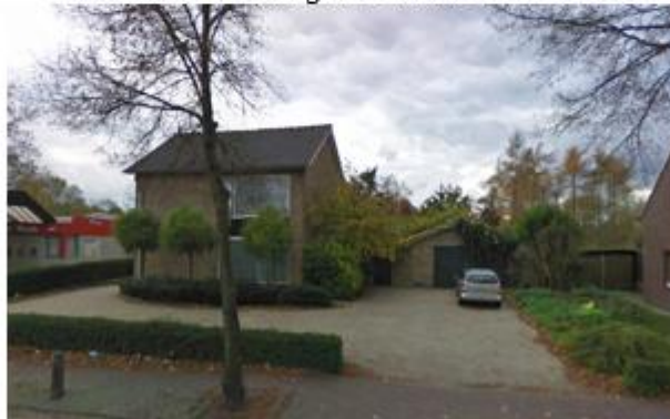
Bestaande woning met inrit en schuur
