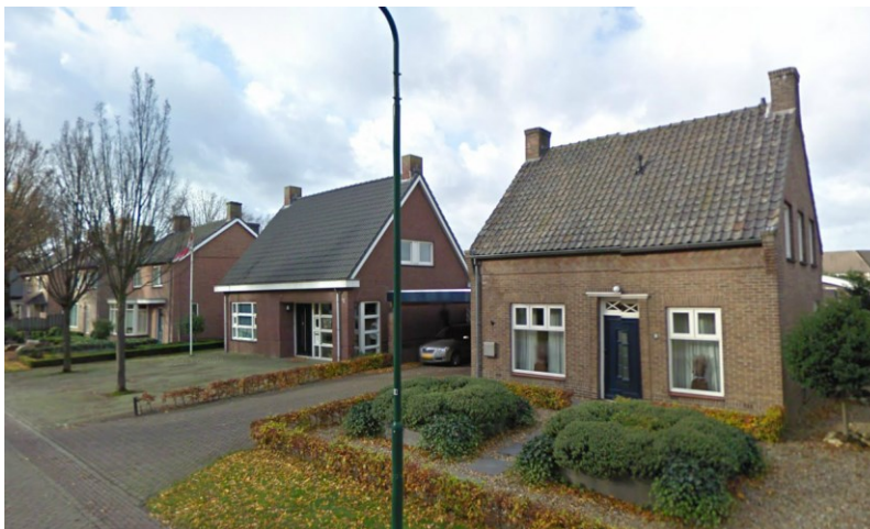
Aanzicht kantoor Schaapsdijk 7 vanuit noorden
