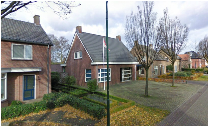
Aanzicht kantoor Schaapsdijk 7 vanuit zuiden
