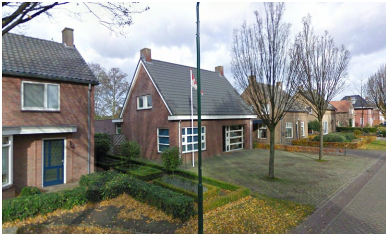
Aanzicht kantoor Schaapsdijk 7 vanuit zuiden
