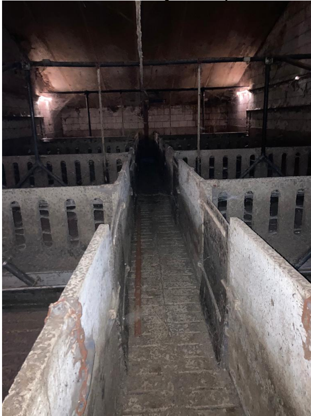
• Afbeelding 17: binnenzijde varkensstallen
