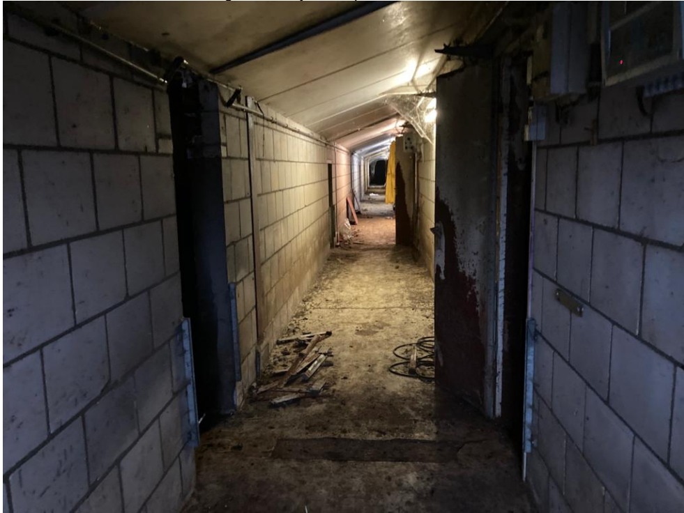
• Afbeelding 5: binnenzijde te slopen stallen meest rechtse stal
