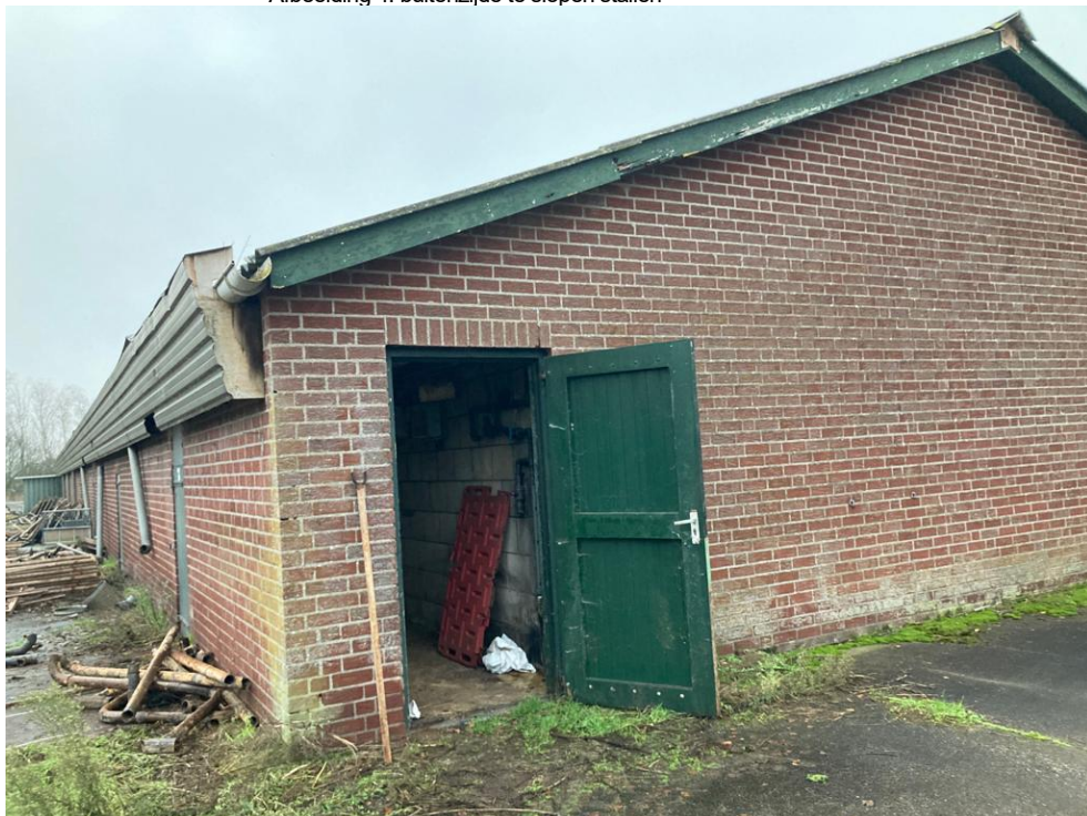
• Afbeelding 4: buitenzijde te slopen stallen
