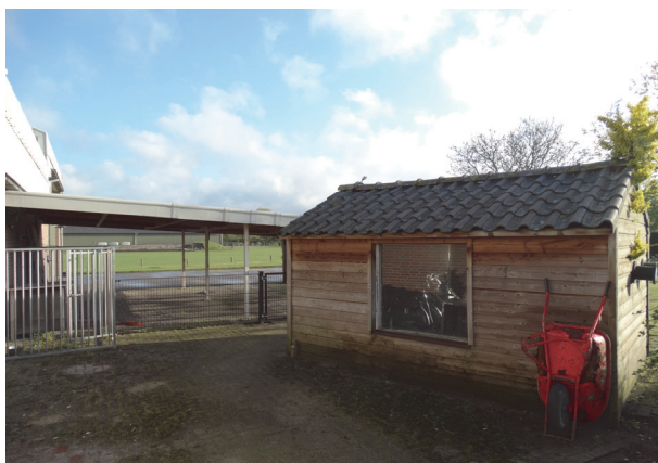
Figuur 7: Aanzicht deelgebied 2 met uitzicht op de te verwijderen tuinhuis, bestrating en afdak
