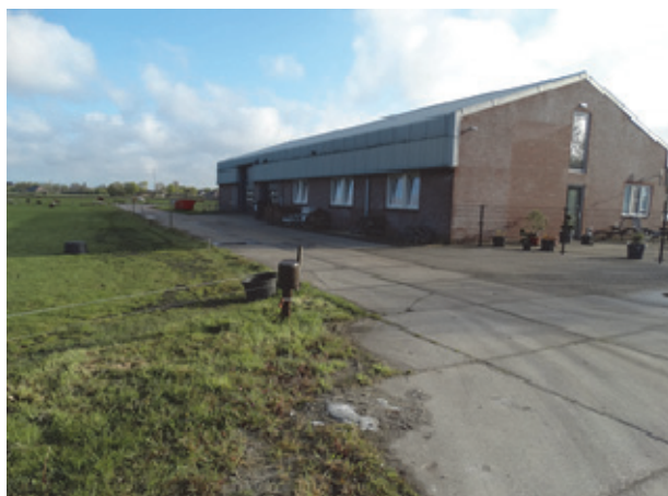
Figuur 5: Aanzicht deelgebied 1 en bedrijfscomplex
