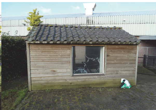
Figuur 8: Achterzijde de te verwijderen tuinhuis
