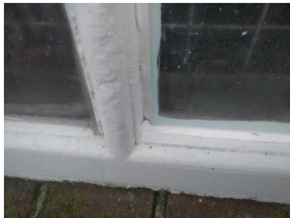
Beton geen asbest
