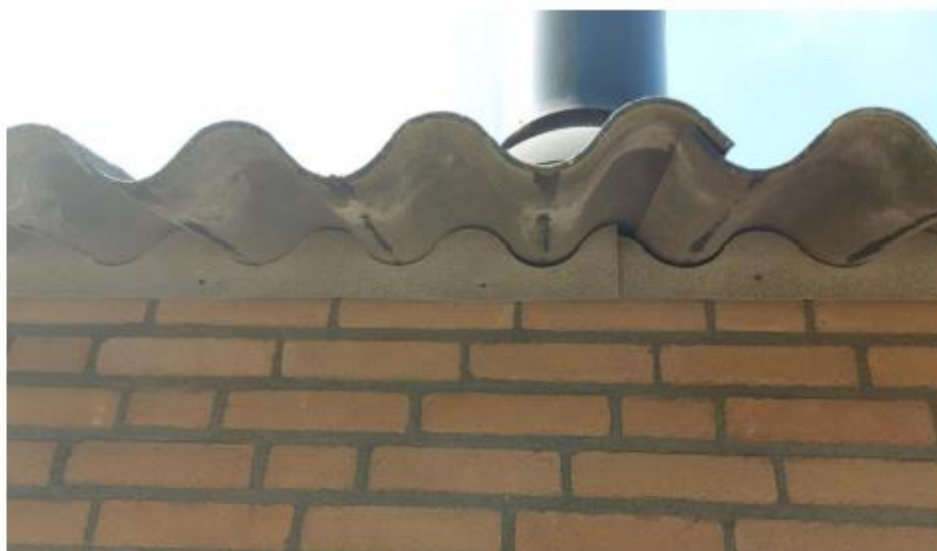
Figuur 36. De stallen op locatie 17 zijn aan de buitenzijde zorgvuldig afgewerkt zodat er geen toegang is voor vogels.
