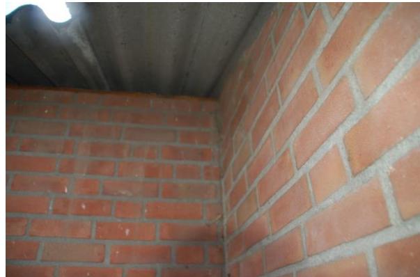
afgesloten dakranden
