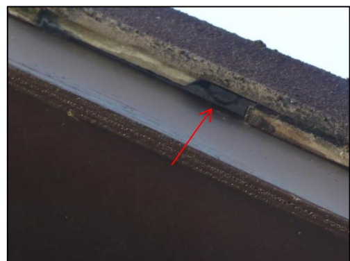
Ruimte achter dakpannen.
