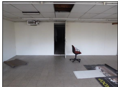
Binnenkant van te slopen pand.
