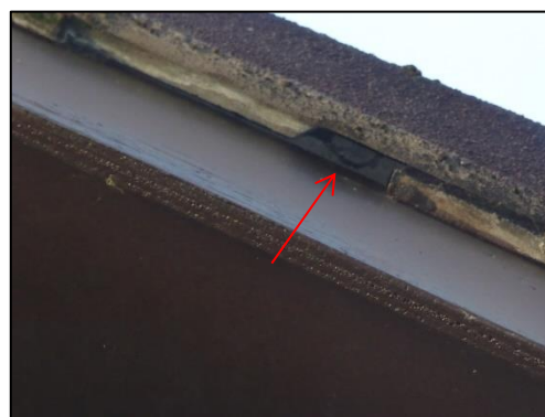
Ruimte achter dakpannen.
