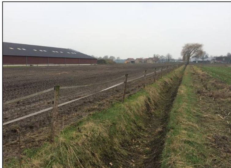
Figuur 5.6: Foto infiltratiesloot, links is stal 4 zichtbaar (d.d. 9 februari 2017)
