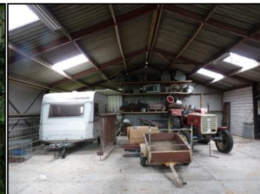
Figuur 5. Binnenzijde loods met golfplaten dakconstructie.
