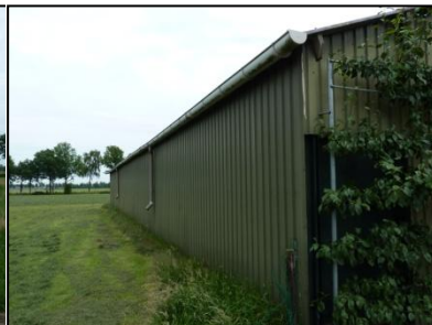
Figuur 4. Zijaanzicht loods welke verplaatst wordt op het terrein.
