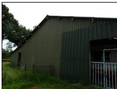
Figuur 6. Achterzijde loods.
